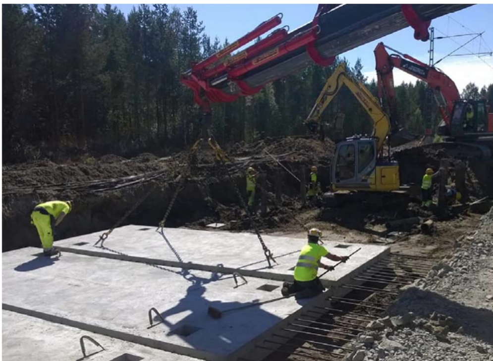
KUVA 5. Elementtilaatta ja sen asennus (Partala 2015, 13).
