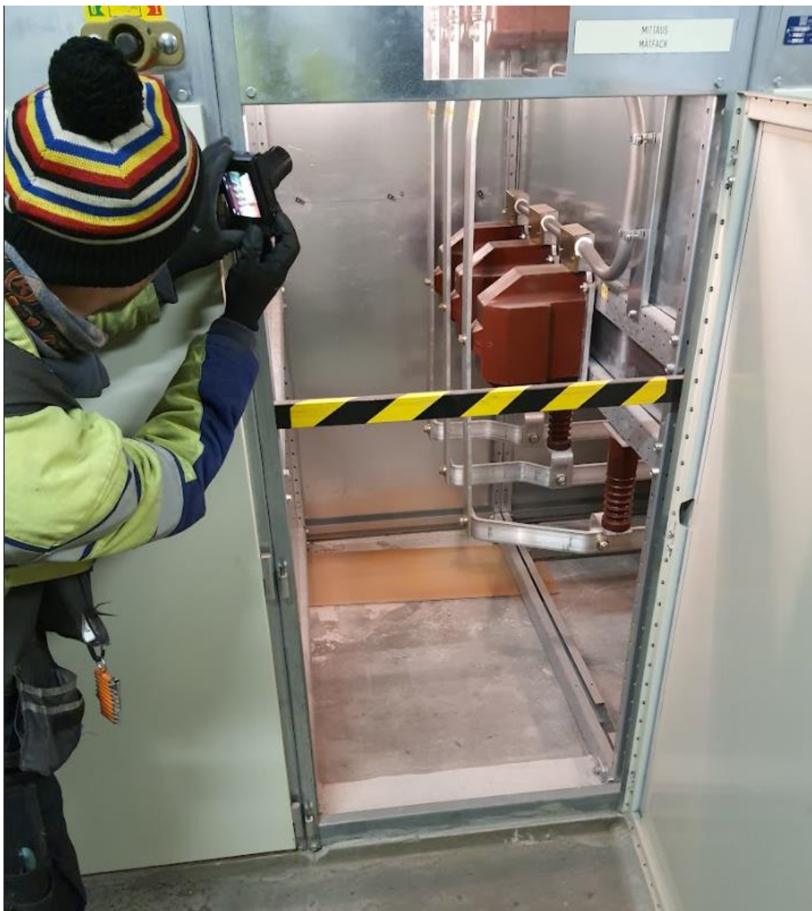
Figur 9. Granskning av strömtransformatorernas faktor med hjälp av att zooma med en kamera.
