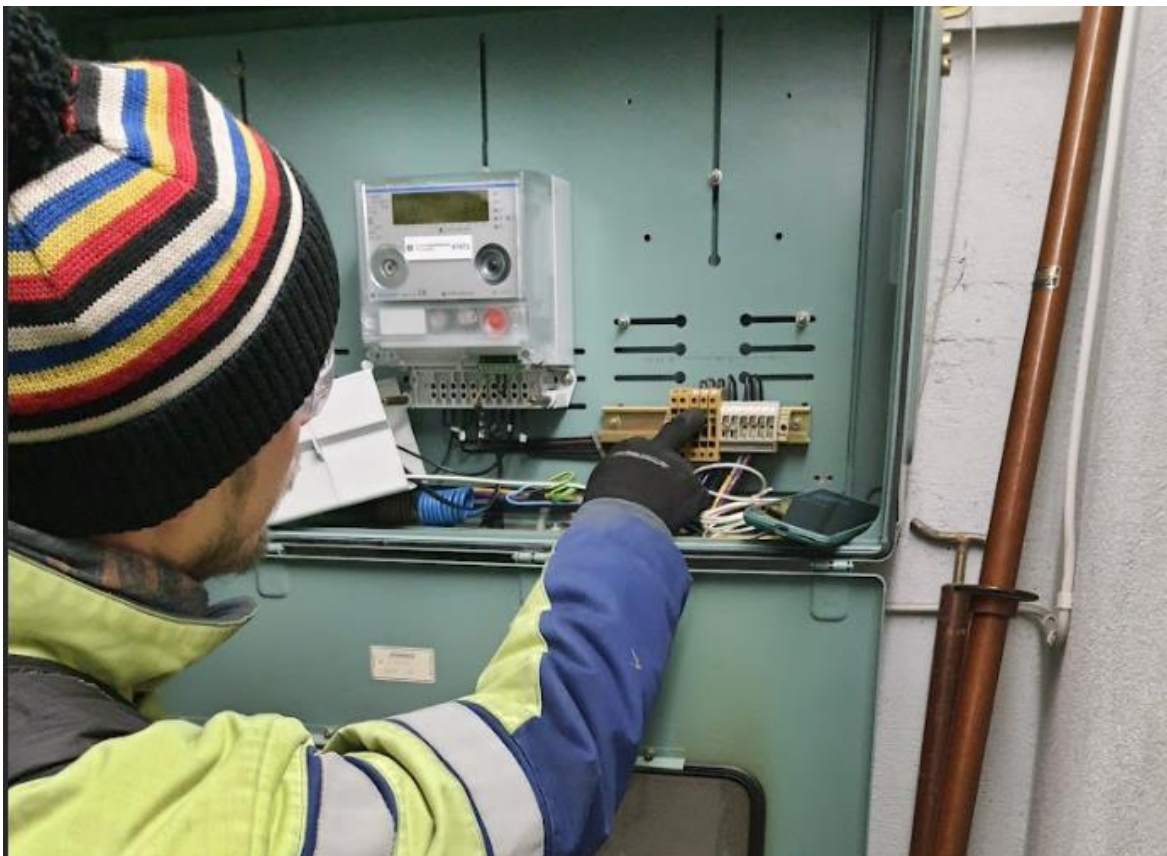
Figur 10. Kortslutning av strömtransformator i terminalen.
