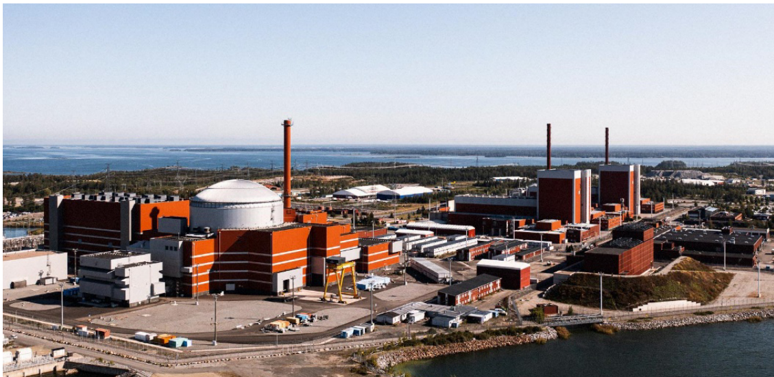
Kuva 1 Olkiluodon laitousyksiköt (Kuva: tvo.fi/tuotanto/laitousyksikot )
