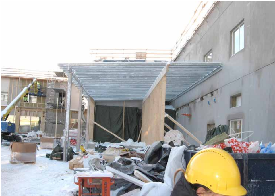
Kuva 3: Kulinaaritalon peruskorjaustyömaasta. (Kuva: Sakari Autio 2013.)
