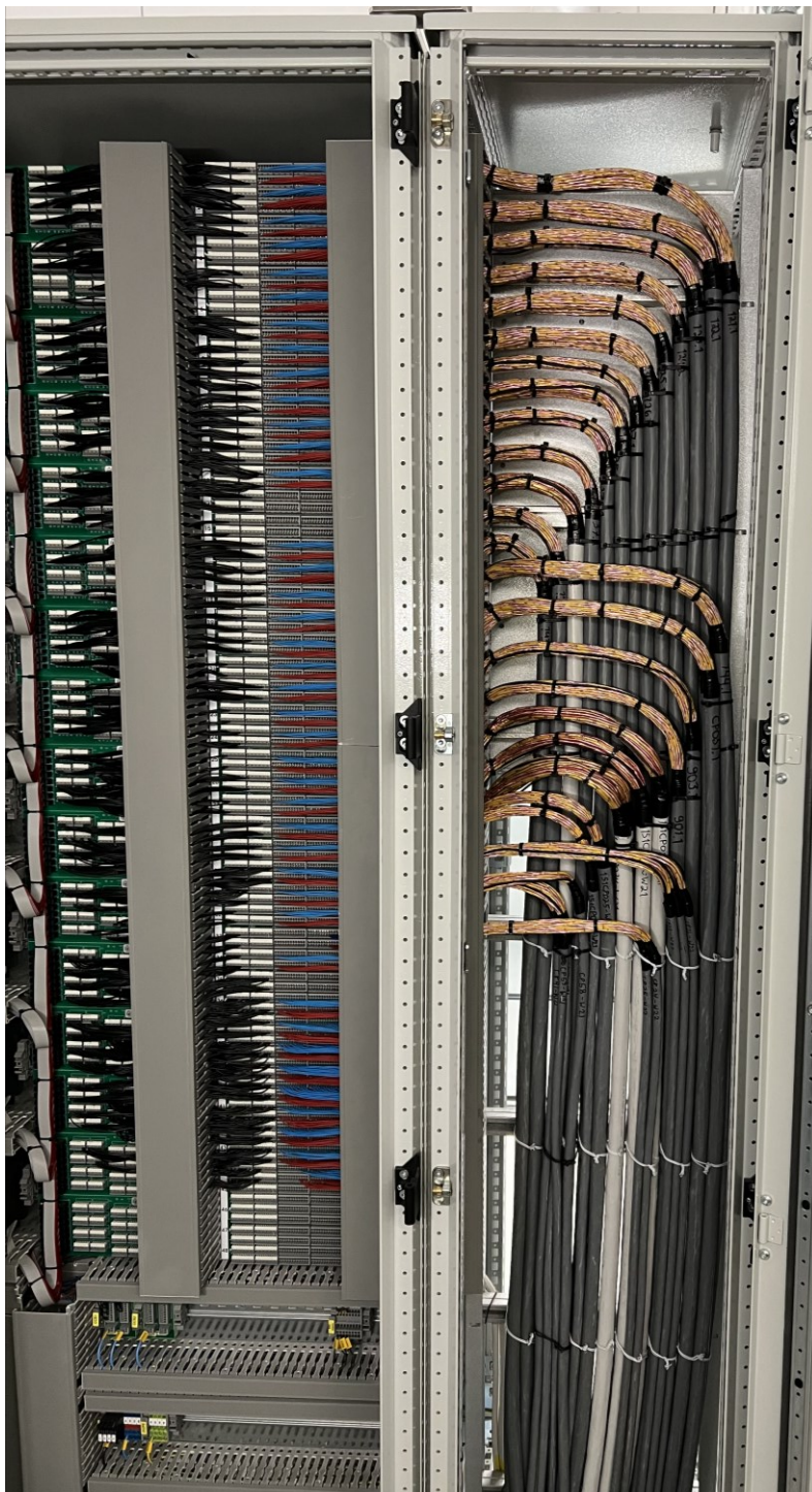
KUVA 16. Runkokaapeleiden nousu ja kytkentä järjestelmäkaappiin.
