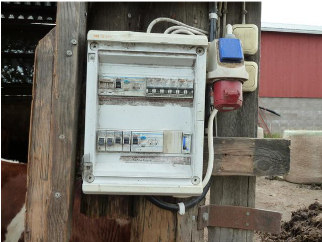
Kuva 2. Puuttuva suojakansi.
