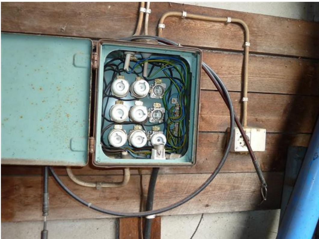
Kuva 4. Puutteellinen kosketussuojaus.
