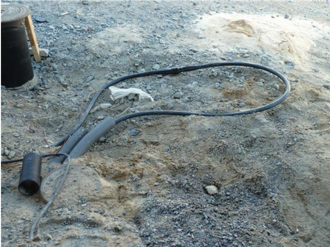
Kuva 6. Jännitteinen liittymiskaapeli maan pinnalla.
