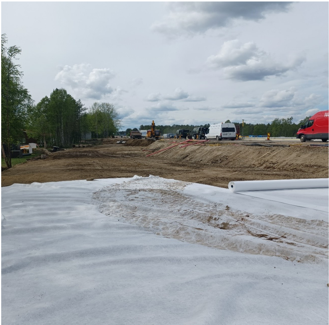
Kuvio 6. Kiertotien alin yhdistelmäpinta eli leikkauspohja (Närhi 2022c)
