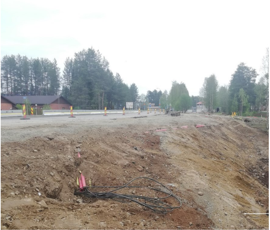
Kuvio 5. Kiertotien pintamaan poistoa ja leikkausta (Paaso 2022b)
