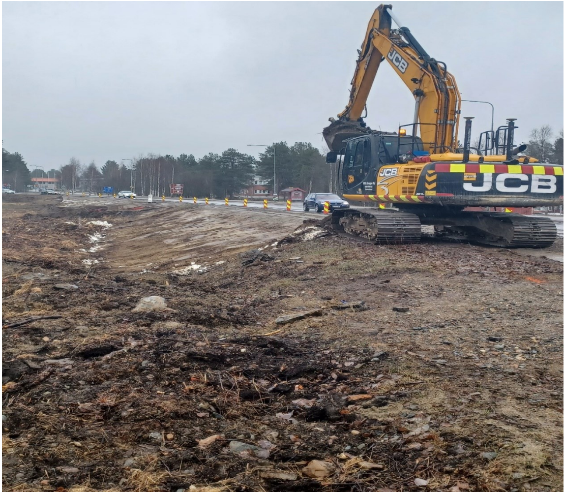
Kuvio 2. Pintamaan poistoa kiertotien aikaisen levennyksen kohdalta (Närhi 2022a)
