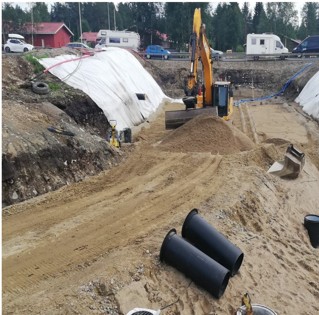
Kuvio 13. K4J-väylän suodatinkerroksen rakentamista (Paaso 2022d)
