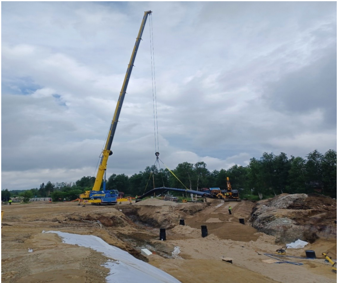
Kuvio 11. Kaukolämpöputkien nosto S2-alikulkukäytävän kaivantoon (Närhi 2022g)
