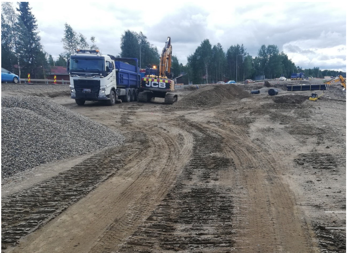
Kuvio 12. Uuden V4-valtatien linjauksen hulevesijärjestelmän rakentamista (Paaso 2022c)
