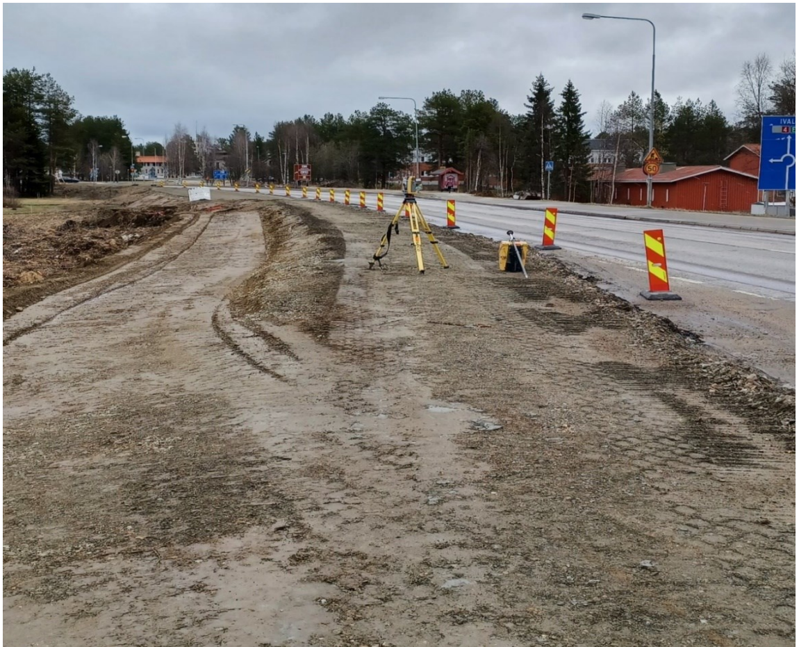
Kuvio 3. Väliaikaisen levennyksen pengerrystä (Närhi 2022b)
