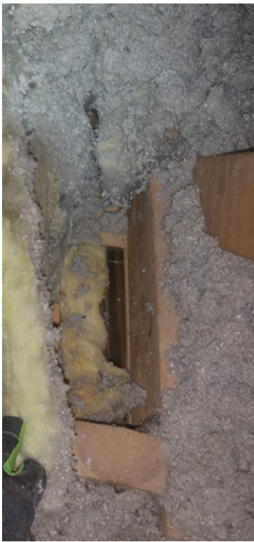
KUVA 5. Väliseinän avoin yläpää
