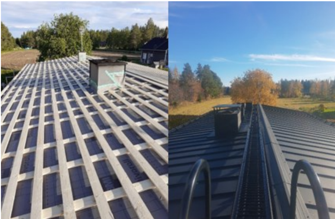
KUVA 8. Yleiskuva rakennusvaiheesta sekä valmiista katteesta.
