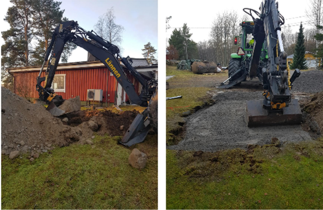
Kuva 21 Öljysäiliön poisto. (Kuva Miro Salmelainen)
