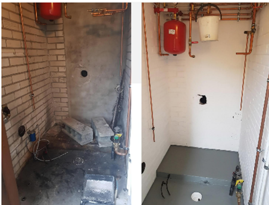
Kuva 22 Pannuhuone ennen ja jälkeen. (Kuva: Miro Salmelainen)
