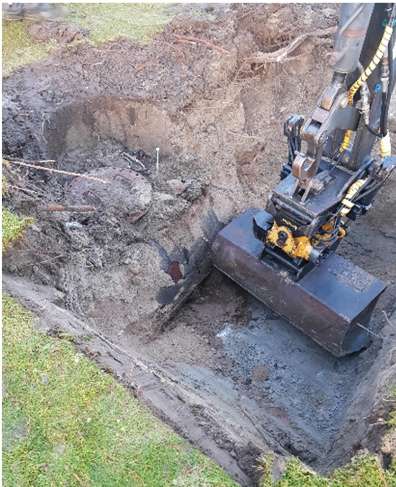
Kuva 7 Öljysäiliön poisto. Betoninen kaivonrenkas osittain huoltoluukun päällä. (Kuva: Miro Salmelainen)
