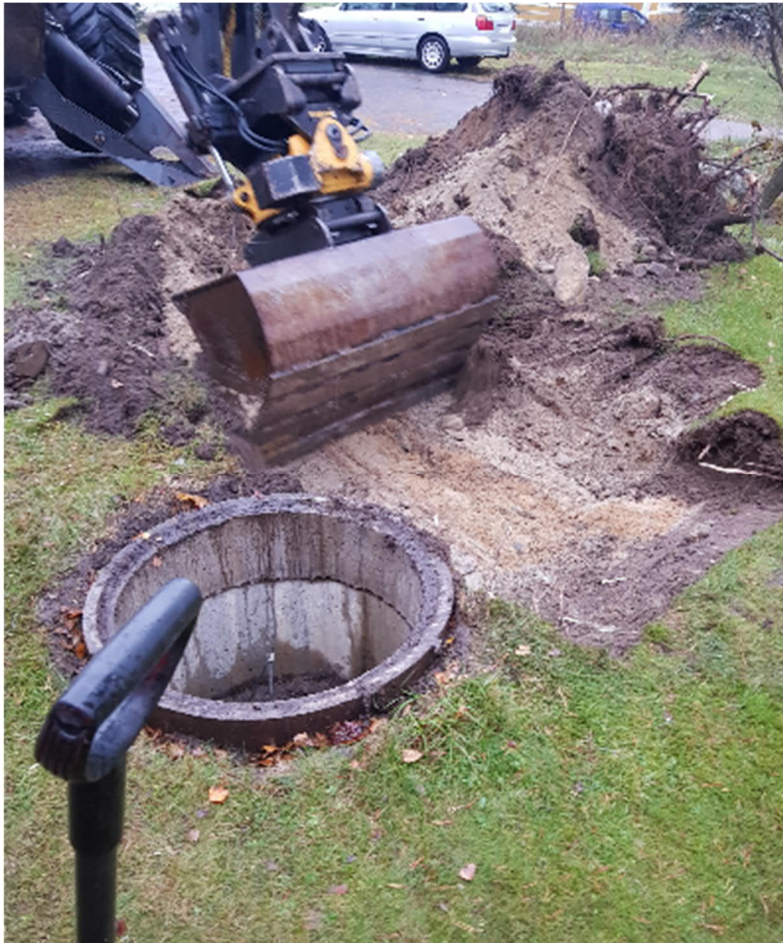
Kuva 20 Öljysäiliön tarkastuskaivo. (Kuva: Miro Salmelainen)
