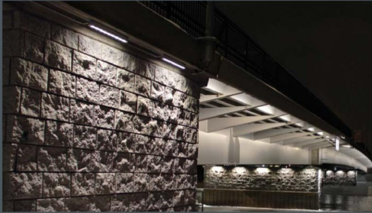
Sirkkalan Silta, Finland Lighting design: Ramboll, Satu Marttila
