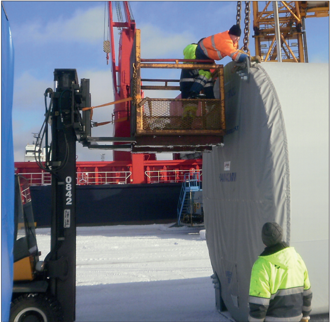
Kuva 4. Apukone ja työskentelyhäkki.
