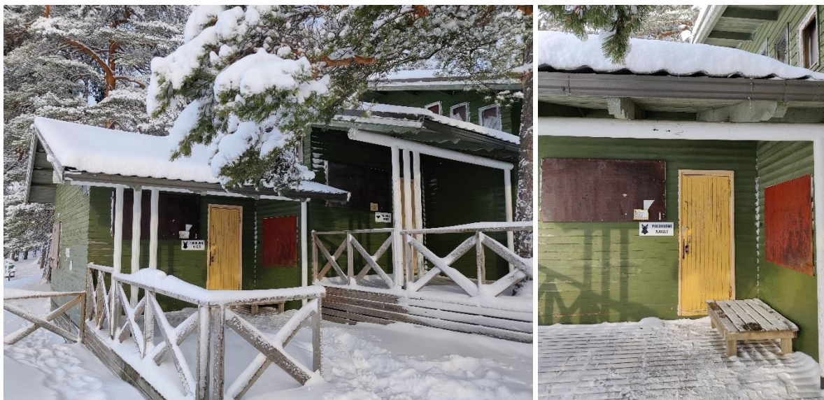
KUVA 12. Olemassa oleva pukutilarakennus (Breiling 2022)
