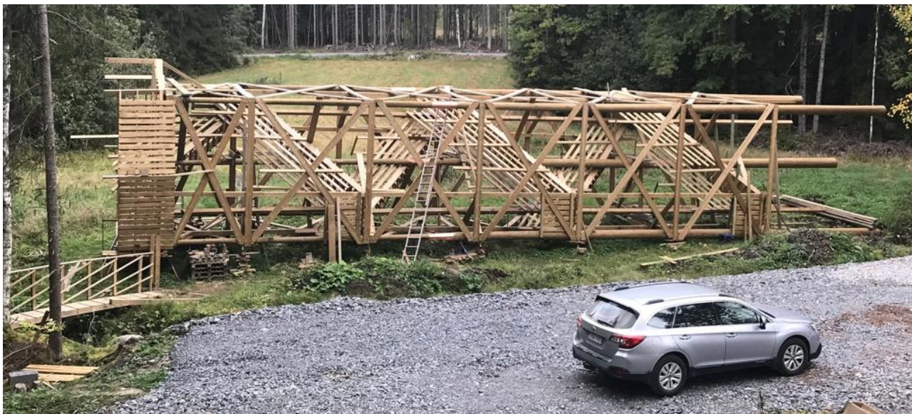
Kuva 1. Torni rakenteilla vaakatasoon (Tuomisto, 2021).
