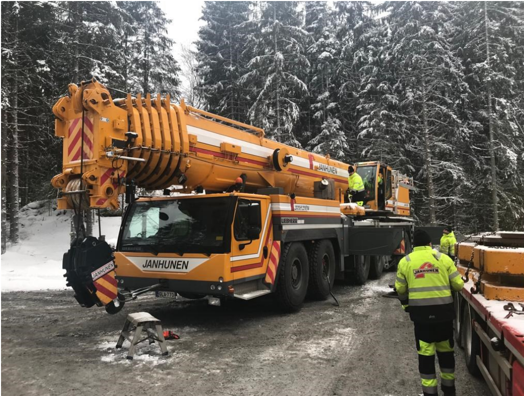
Kuva 5. 300 tn nosturi saapui työmaalle (Tuomisto, 2022).
