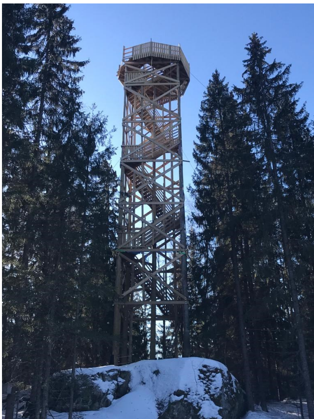
Kuva 6. Torni nostettuna paikoilleen kallion päällä (Tuomisto, 2022).
