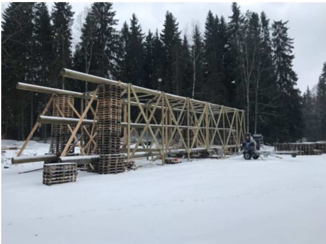
Kuva 3. Tornin pilarit tuettuna trukkilavoilla (Tuomisto, 2021).
