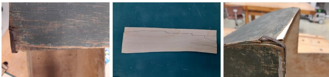
Kuva 15. Kattokuomun viilulohkeaman paikkaus ja liimaus (Henelius 2022)
