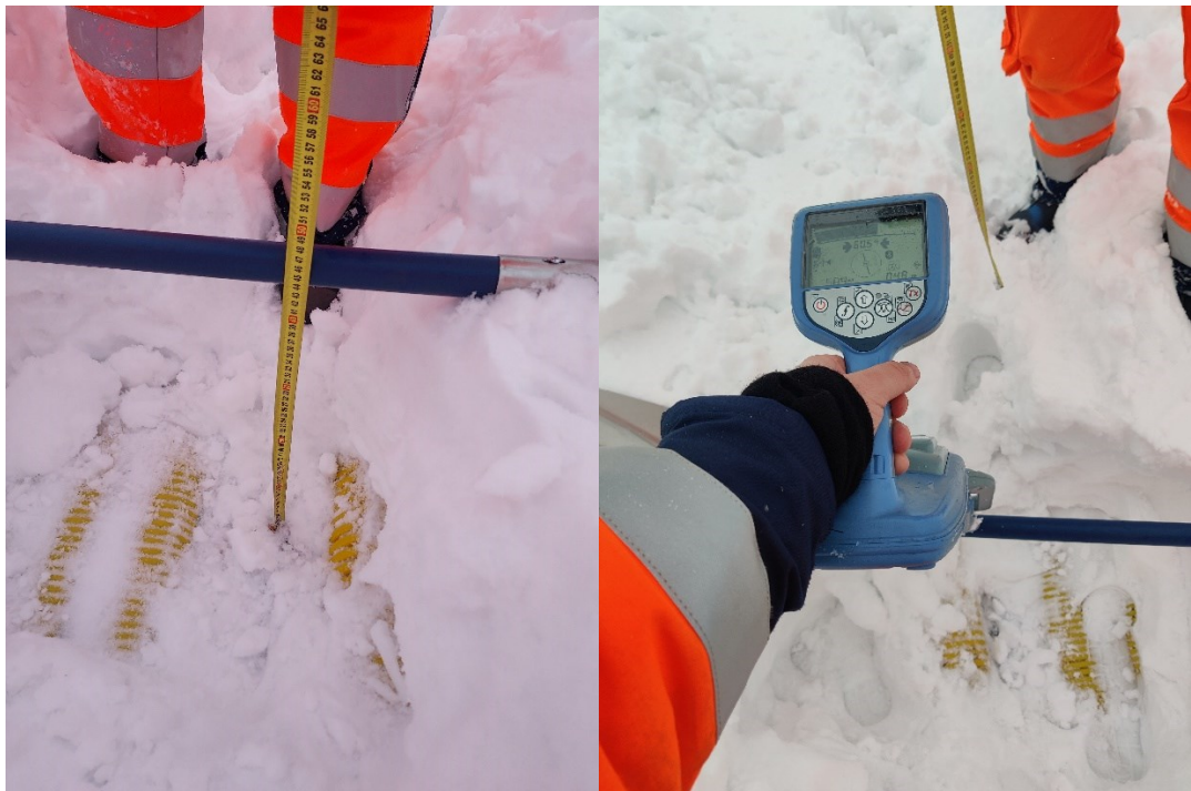
Kuva 11. Syvyydsmittauksen luotettavuuden testaamista
