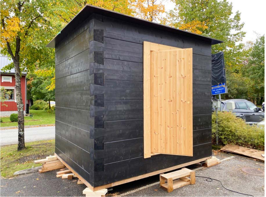
Kuva 1. Projektissa toteutettiin demonstraatio, jonka avulla selvitettiin massiivipuurakenteen lämpö- ja kosteusteknistätoimivuutta sekä rakenteen muodonmuutoksia. Kuva: Mikko Matveinen.
