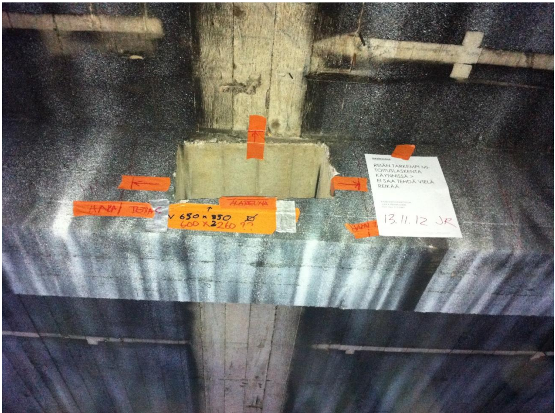
Kuva 19. Varausten merkitseminen ja tarkemittauksia työmaalla [12]
