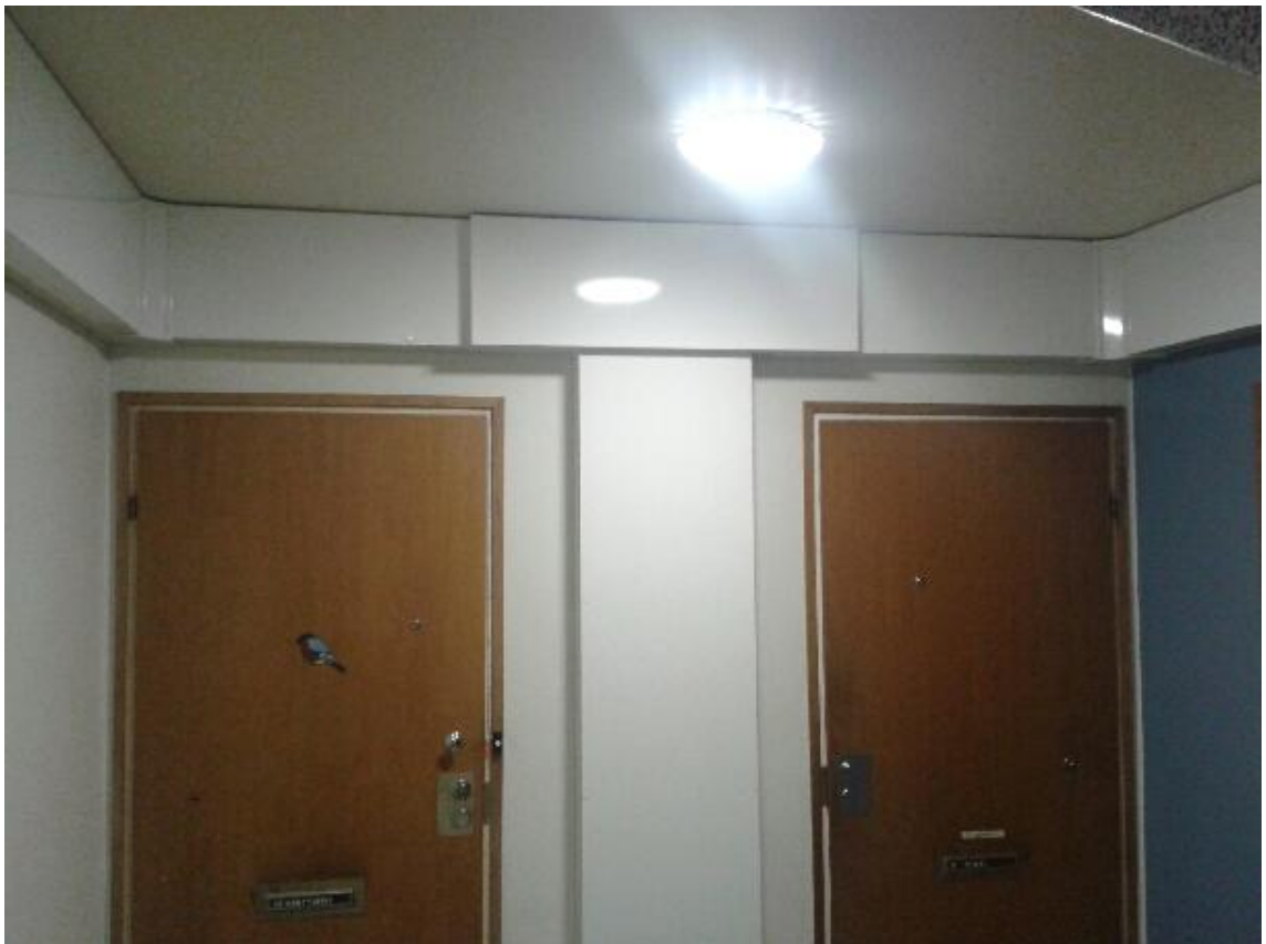
Kuva 20. LV-järjestelmän sijoitus porrashuoneeseen, peltikotelointiin [29]
