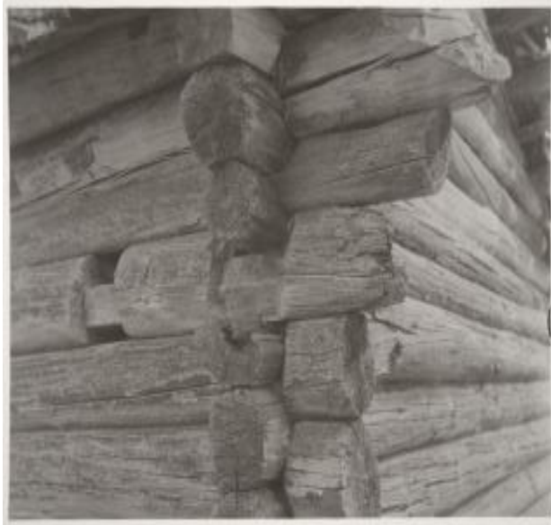
Kuva 3. Valokuva 1920-luvulla rakennetusta salvosnurkasta. [Kuvakokoelmat 2014.]
