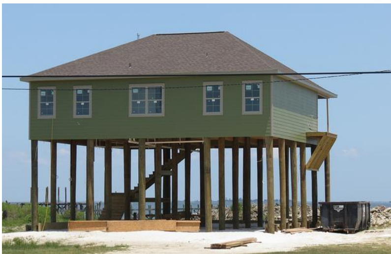
Kuva 34. Talo, jossa tulvaan on varauduttu korkeusaseman korottamisella. [ODN 2014.]
