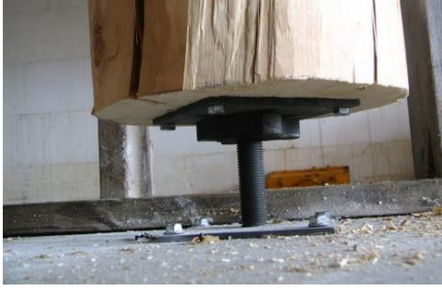
Kuva 17. Pystypilarin alapään säätökierretanko. [Ihoti 2014.]
