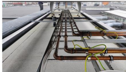
Laitteisto ja linjasto tulee olla maadoitettuna
