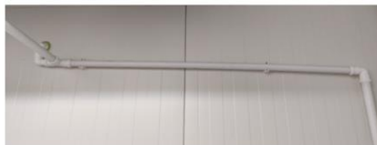
Mallikuva 19. Putkena käytetään valkoista 32mm muoviputkea
