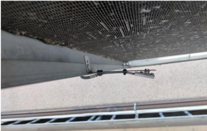
Kaasunjäähdyttimen anturin sijoitus suojaosassa paikassa
