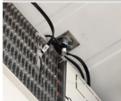
Mallikuva 18. Höyrystimet tulee aina kiinnittää pulteilla min. 8mm sekä prikkoja täytyy käyttää
