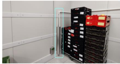
Mallikuva 23. Kaikki törmäyksille alttiit pystyviemäroinnit tulee suojata törmäyssuojalla
