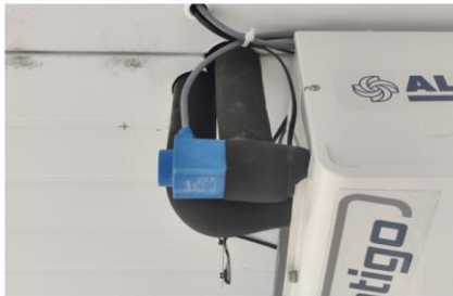
Mallikuva 27. Pääsuntaventtiilit täytyy eristää
