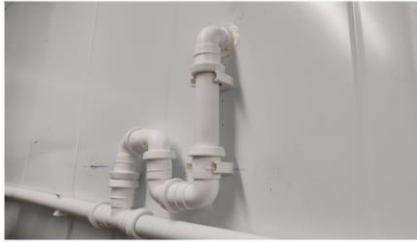
Mallikuva 21. Pakastehuoneiden putkiliinjoon tulee tehdä järeä vesilukko
