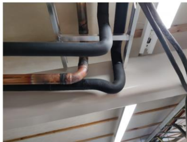
Imulinjan olyppussi nousukohdassa
