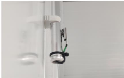
Mallikuva 24. Lämpötila-antureina käytetään Danfoss AKS-11. Jäätä anturi putken päädyssä ulkopuolelle ja kiinnittää se rippusiteellä.
