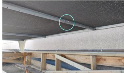
Mallikuva 17. Kaasunjäähdyttimen antureiden sijoitus kuvan mukaisesti. Aina varjotsoan paikkaan, pilossa suoralta auringonpaisteelta
