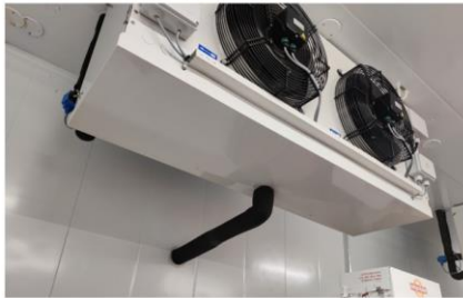
Mallikuva 22. Pakastehuoneiden viemäröinnissä tulee viemäri tuoda ulos pakastehuoneesta ns. lyhyttä järkevintä reittiä pitkin. Viemärointi eristetään 15mm Armaflex eristeellä
