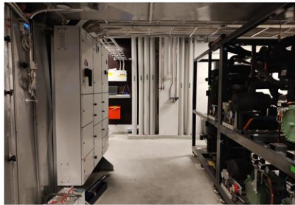
Mallikuva 9. Koneikon ja kalustesähkökeskuksen eteen täytyy jäädä min. 800mm vapaata tilaa
