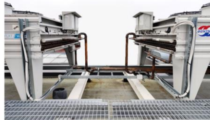
Mallikuva 12. Kuumakaasulinjan nousuissa on aina oltava ylä- ja alaläpypussit
