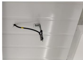
Puhallusilma-anturi kannakointipeltissä
