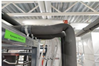
Mallikuva 7. Imulinjojen nousukohtain on tehtävä olymutkat
