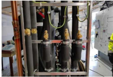
Mallikuva 8. Neste- ja imulinjoihin tulee tehdä huoltosulut
