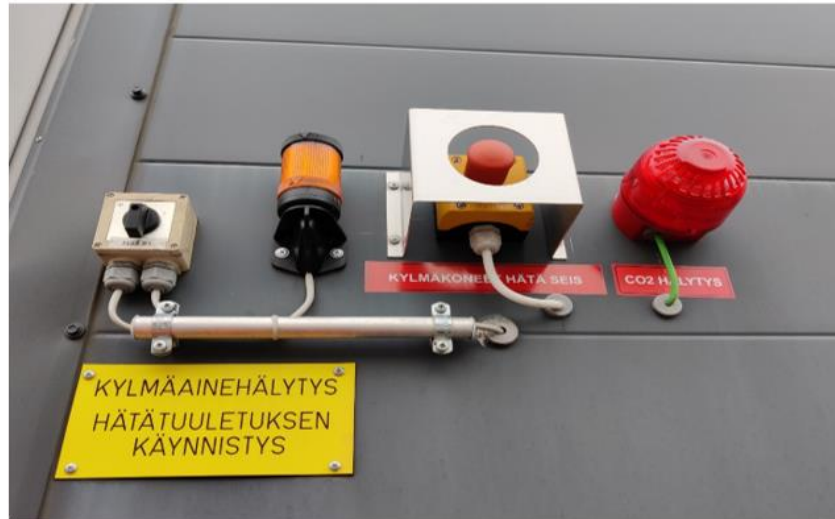
Mallikuva 34. Konehuoneen ulkoseinän hälytysvilkut
