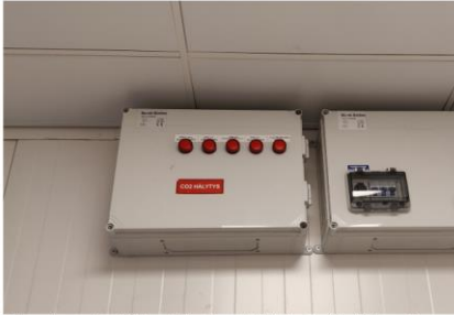
Jos huoneita on useita peräkkäin, merkataan lampun kohdalle tarrailla, että mistä huoneesta on kysymys
