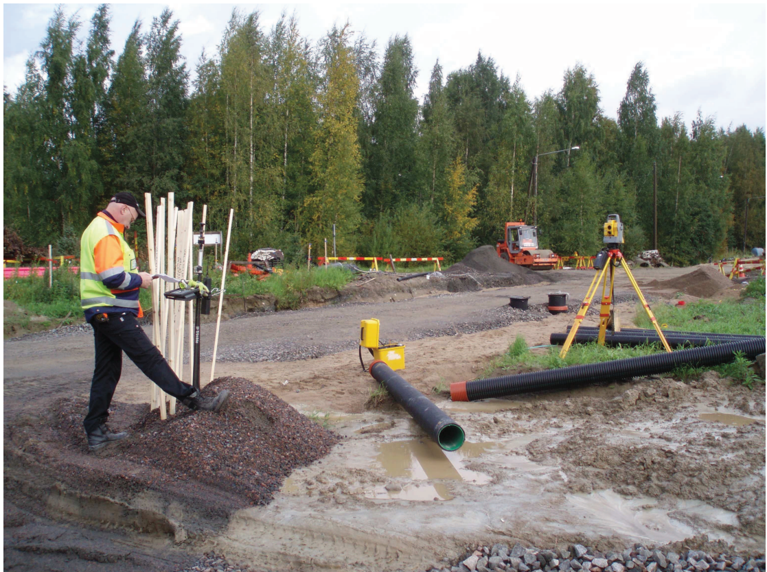
Kuva 2. Katupaalutusta robottivarustuksella.
