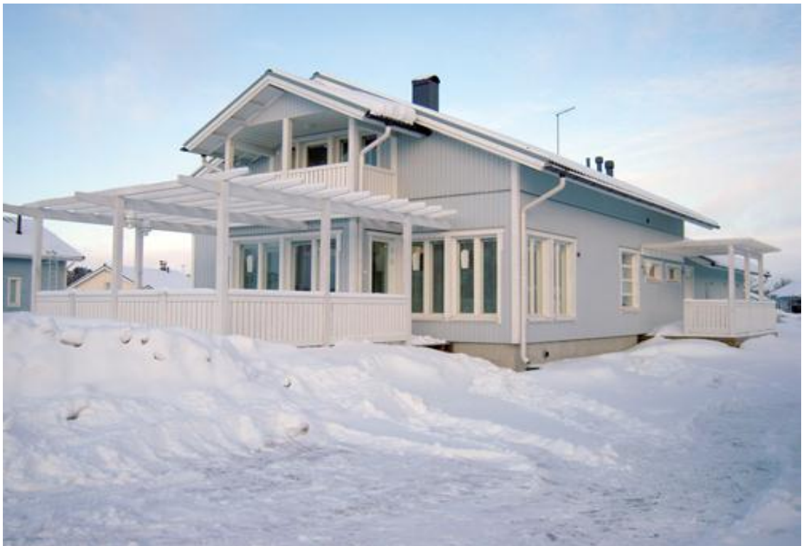
Kuva 1. Opiskelijatyönä rakennettu omakotitalo, julkisivu länteen. (Turun ammatti-instituutti 2011.)
