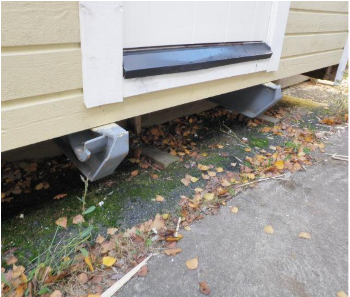
Kuva 4. Siirtolavapohja työmaatilan alla, kulkuovi lavapohjan keskilinjassa.
