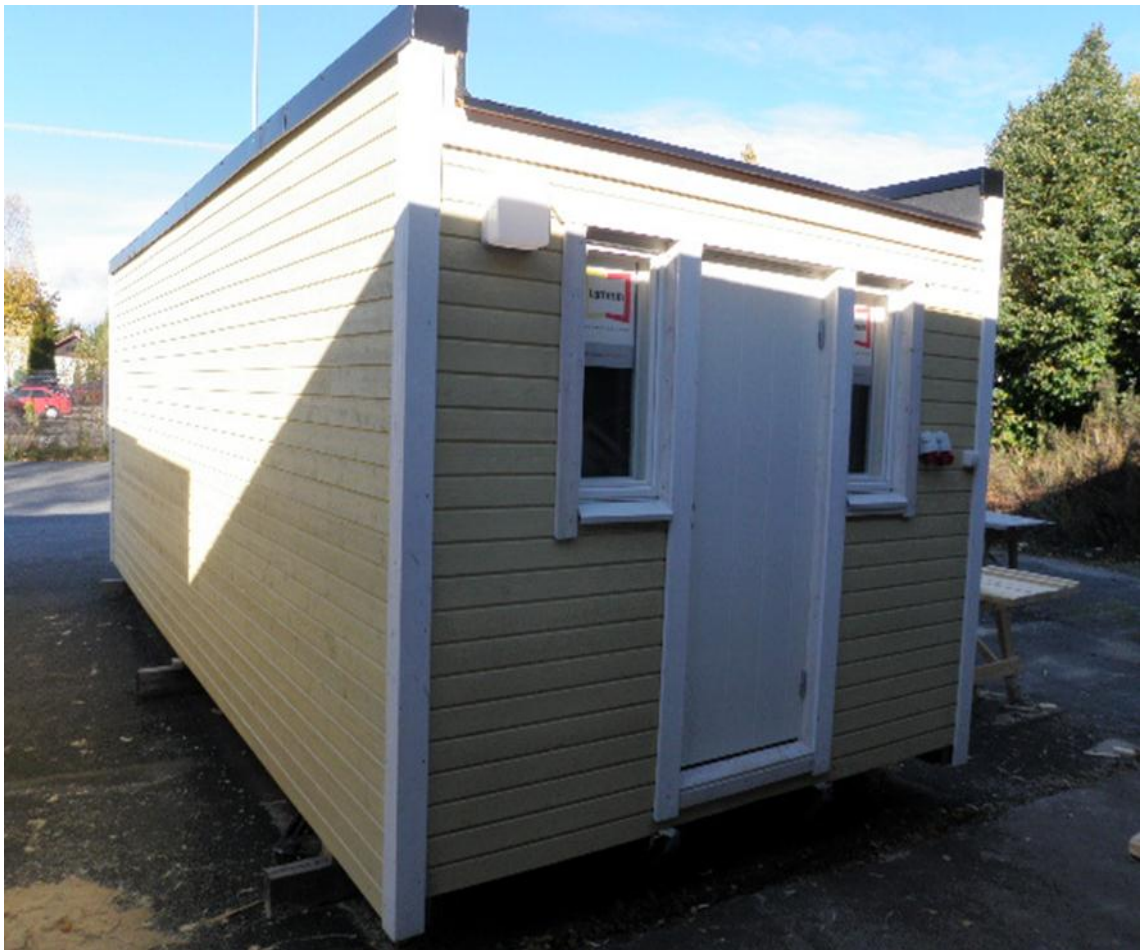
Kuva 6. 2-osainen varasto, takaosa.
