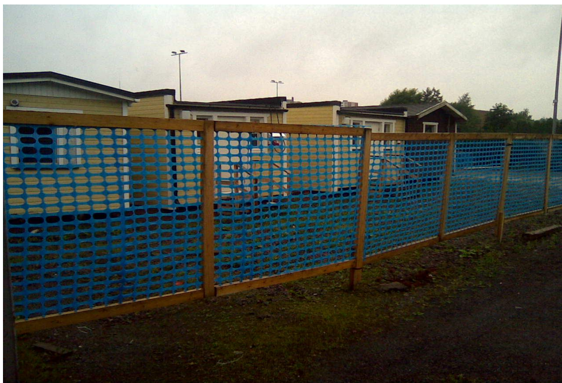
Kuva 18. Muoviverkosta ja laudasta valmistetut työmaan aitaelementit.
