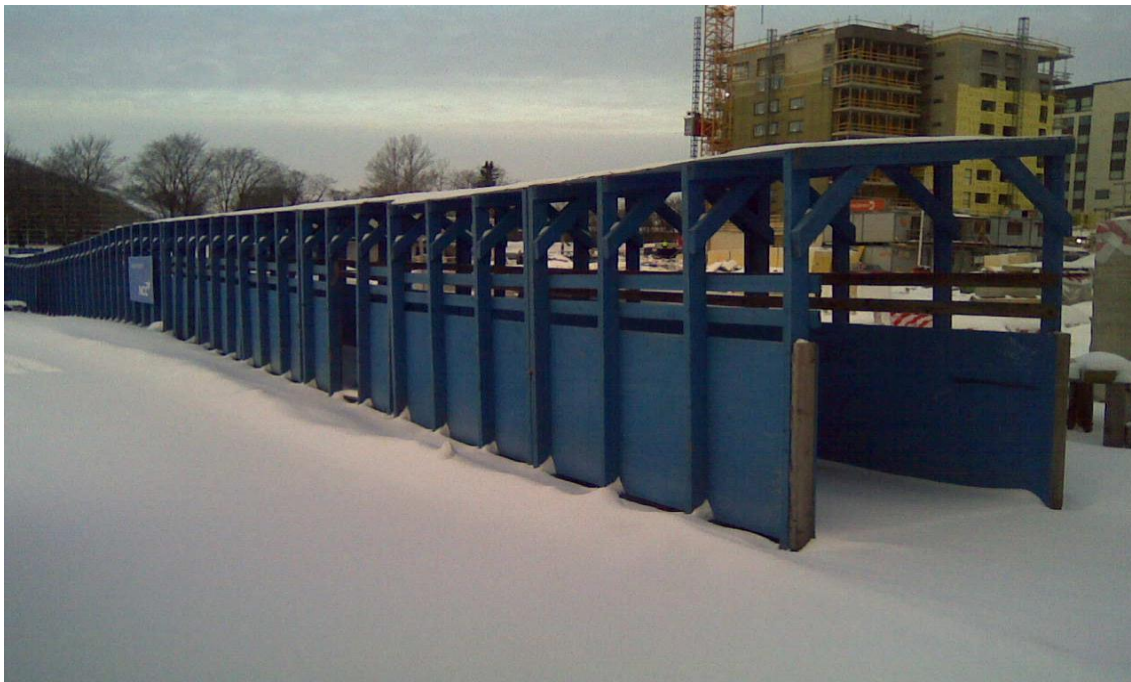
Kuva 15. Kulkukatosselementeistä koottu yhtenäinen kulkukatos.
