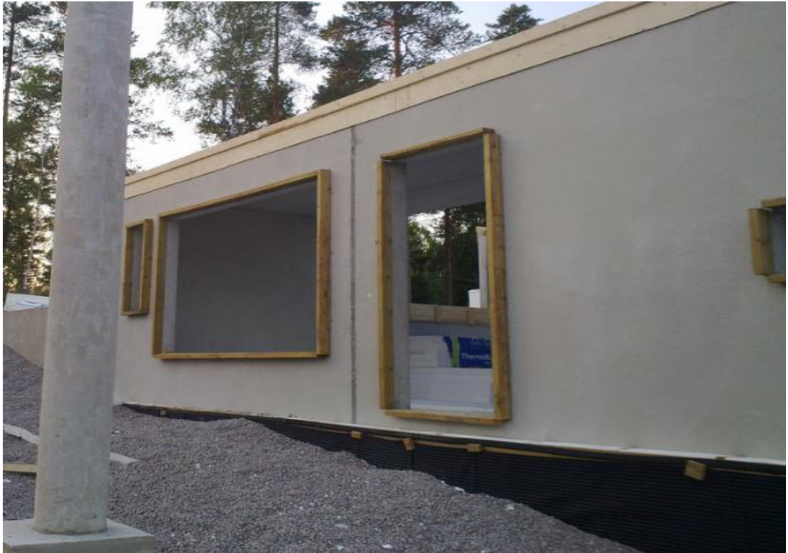
Kuva 17. Apukarmirakenteet asennettuna betonielementtien ulkopintaan. (Tulevaisuudentalo [verkkodokumentti, viitattu 4.8.2013].)
