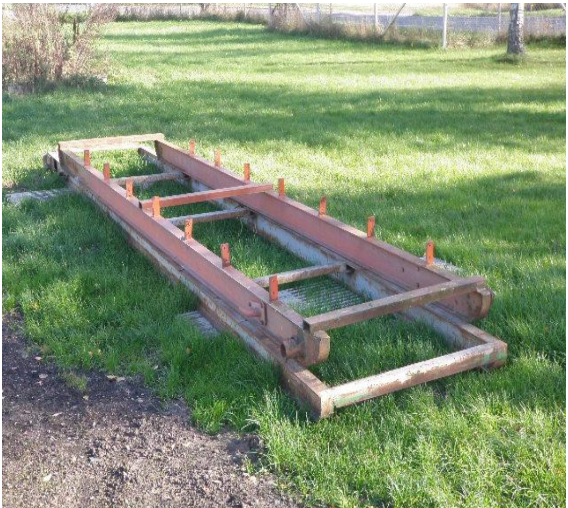
Kuva 3. Rakennettavien työmaatilojen siirtolavapohjia.
