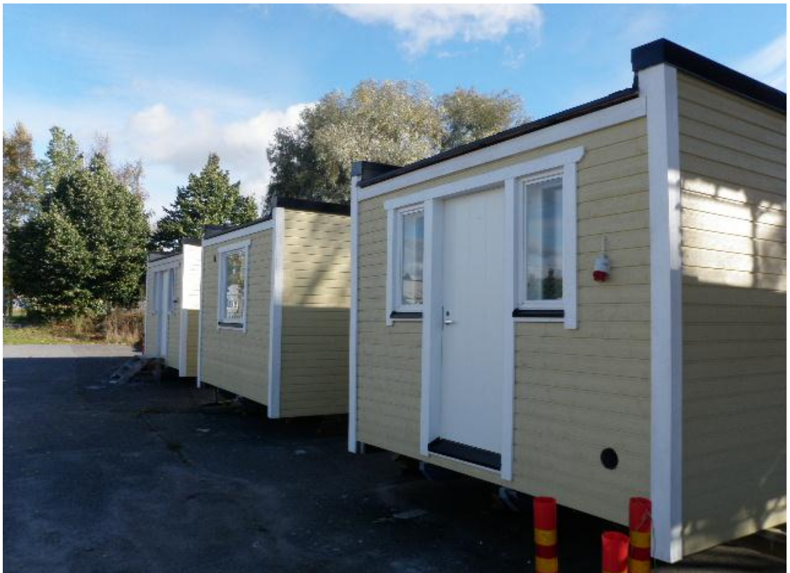
Kuva 5. Rakenteilla olevia eri käyttötarkoitukseen soveltuvia työmaatiloja.
