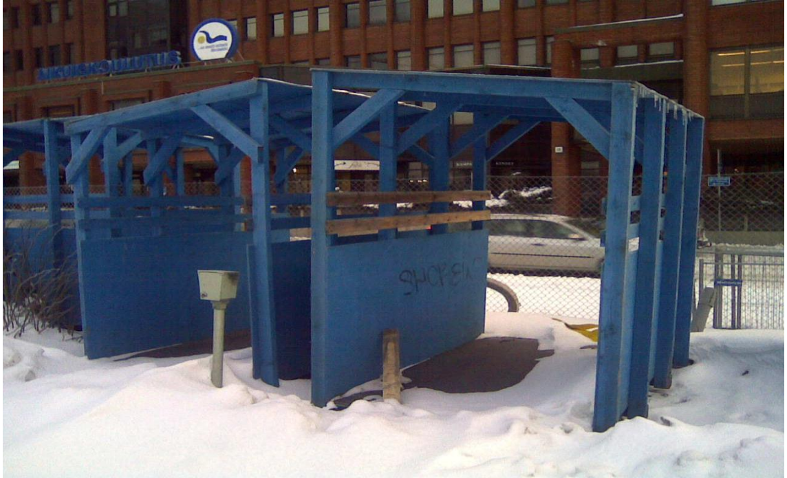
Kuva 14. NCC Rakennus Oy:n kulkukatosselementtejä.
