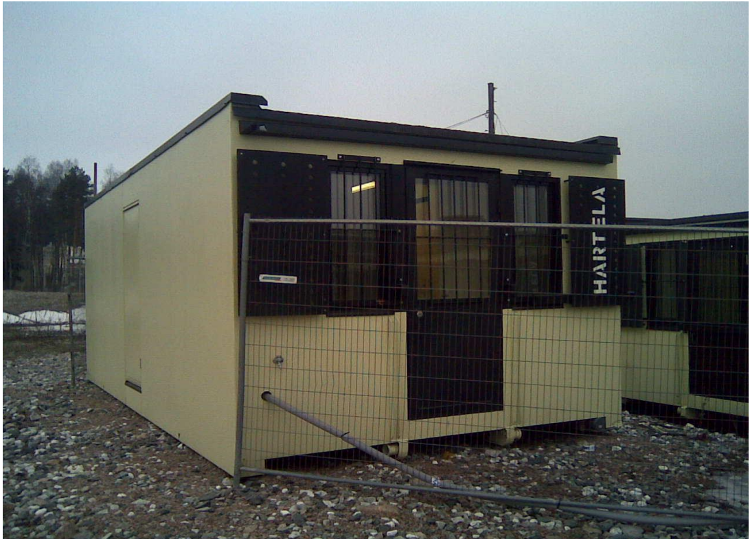
Kuva 16. Hartela Oy:n siirrettävä työmaatila.
