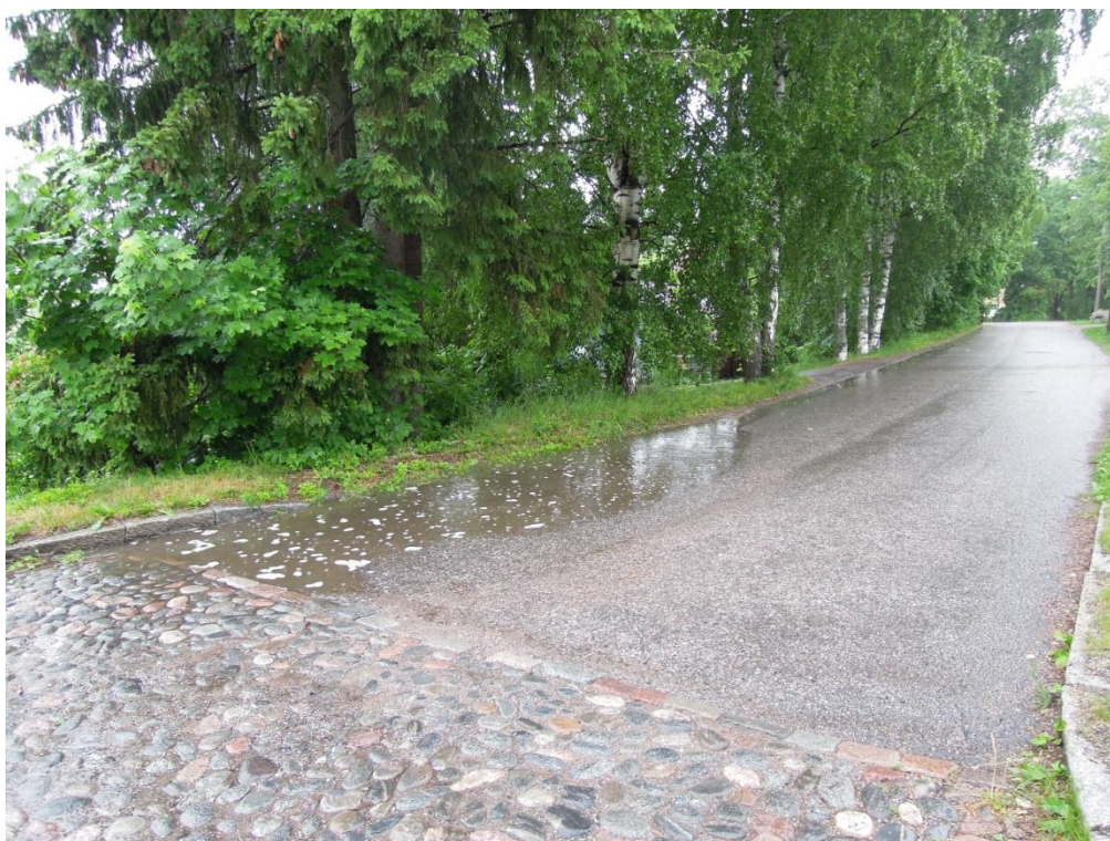
Figur 15. Vattenpöl som bildats vid korsningen mellan Gamla Kungsvägen och Julinsgränd.
