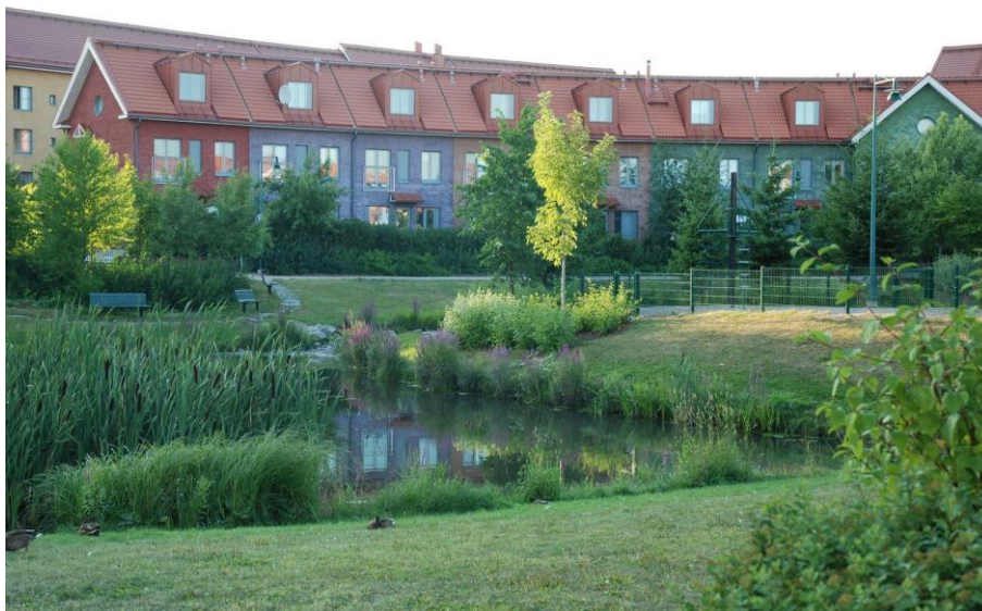
Figur 5. Infiltrationsdammen . Infiltrations- eller fördröjningsdammar kan fungera som tilltalande vattenelement på bostadsområden. (Bild: Henri Nieminen 2013).
