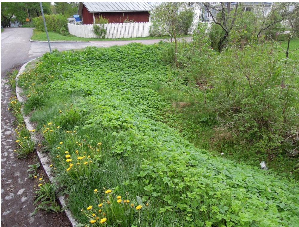
Figur 16. Kantstenen vid Gamla Kungsvägen hindrar dagvatten från att rinna ner i diket.
