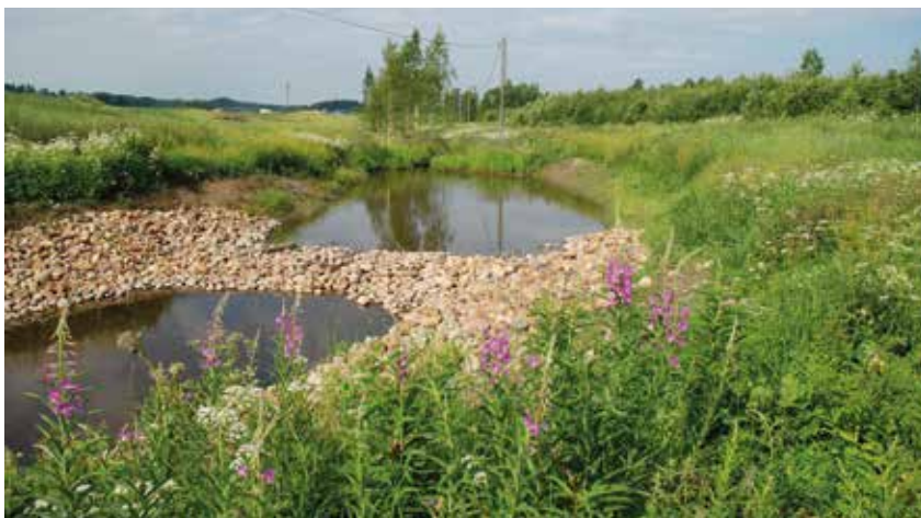
Kuva 16 Perattuun puroon rakennettu pohjakynnykset, jonka yläpuolelle on kaivettu pieni laskeutusallas (Henri Solismaa)
