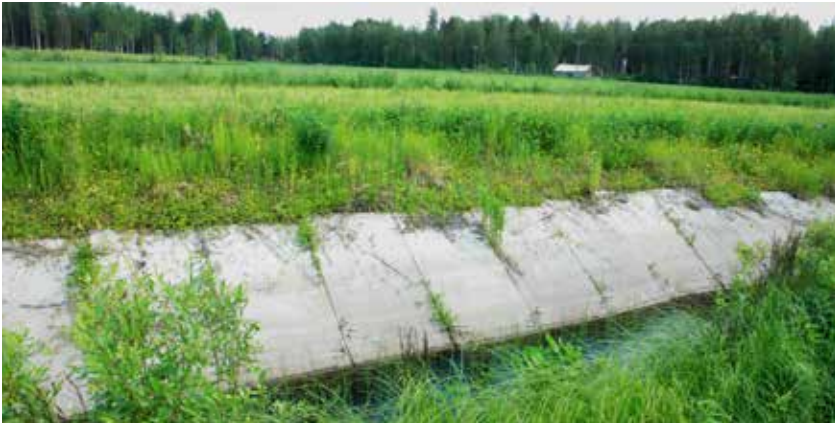
Kuva 15 Betoniset eroosiolaatat Tammelan Heinijoessa (Ida-Mari Toivonen)
