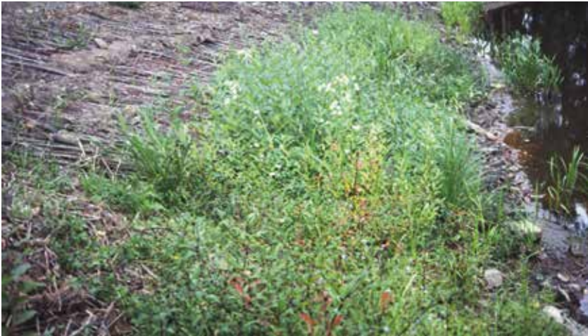
Kuva 14 Ojan luiskien eroosiosuojausta pajumatolla (Lasse Järvenpää)
