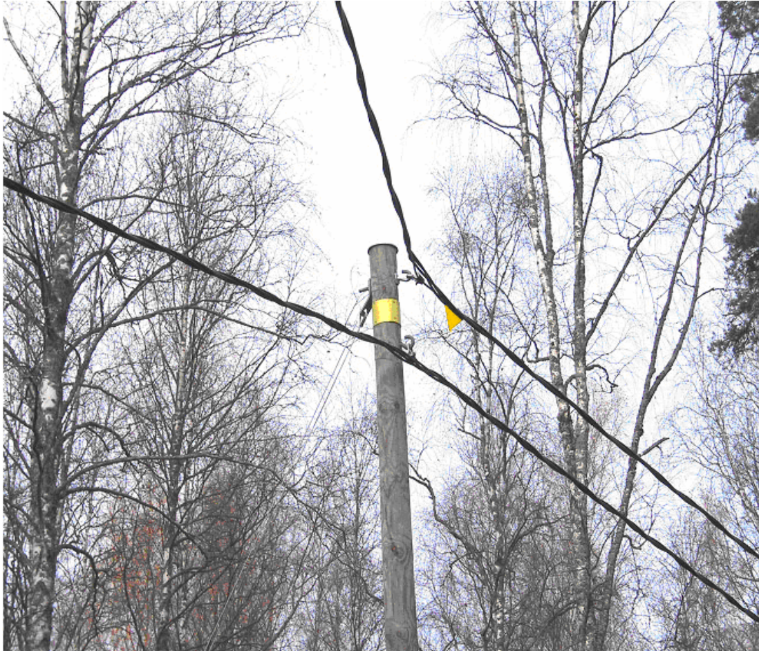
Kuva 4 Pylväinen merkintä 400V ja 1000V yhteispylväässä
