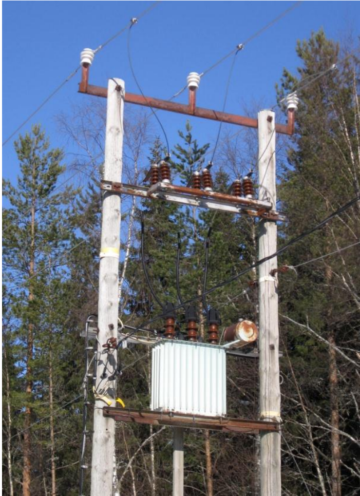
Kuva 1. 20/0,4 kV. Strömbergin n. 30 kVA:n jakelumuuntaja vaijeriohjatulla erottimella. Sukeva (1.)
