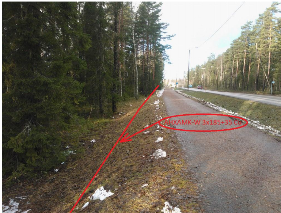
KUVA 2. Uusi 20 kV maakaapeli AHXAMK-W 3x185+35 Cu kaivetaan pyörätien viereen. (Jukka Leino 2012.)
