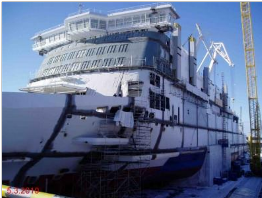
KUVA 4: Valmiiksi yhteen hitsatut lohkot näkyvät kuvassa tummina lohkorajoina (4)
