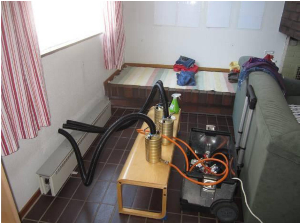
Kuva 15. Ilmanäytteenotto rakenteista. Kuntotutkimusraportti, 2012.
