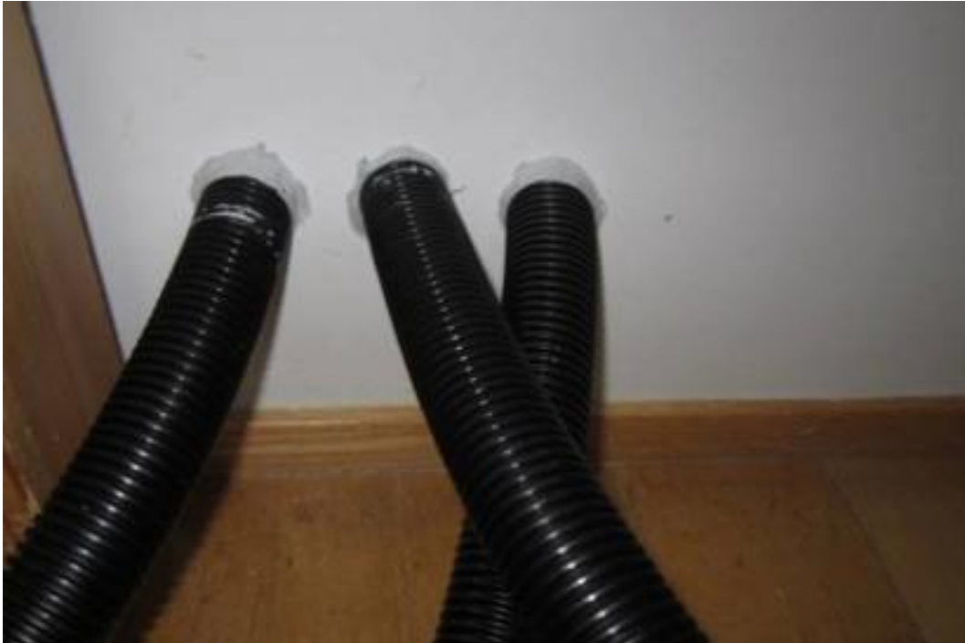
Kuva 13. Imuputket tiivistettiin seinään. Kuntotutkimusraportti, kohde A, 2012.
