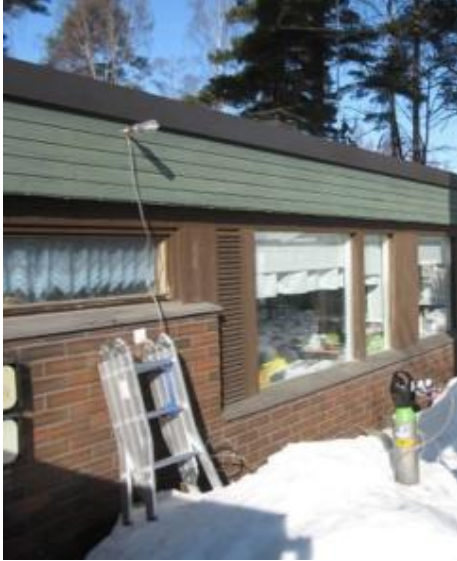
Kuva 16. Merkkiainetta johdettiin yläpohjaan putken avulla. Kuntotutkimusraportti, 2012.
