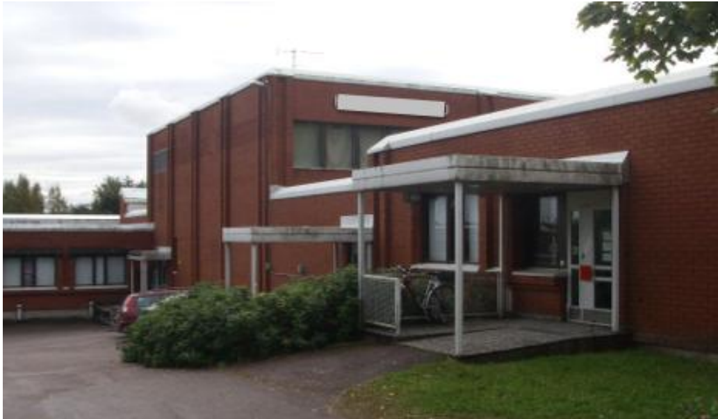
Kuva 19. Kohde D. Ilmanvaihdon kuntotutkimusraportti, 2008.
