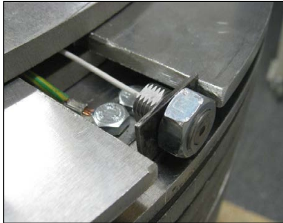
Kuva 41. NC-DVRT-anturi asennettuna uratelaan.
