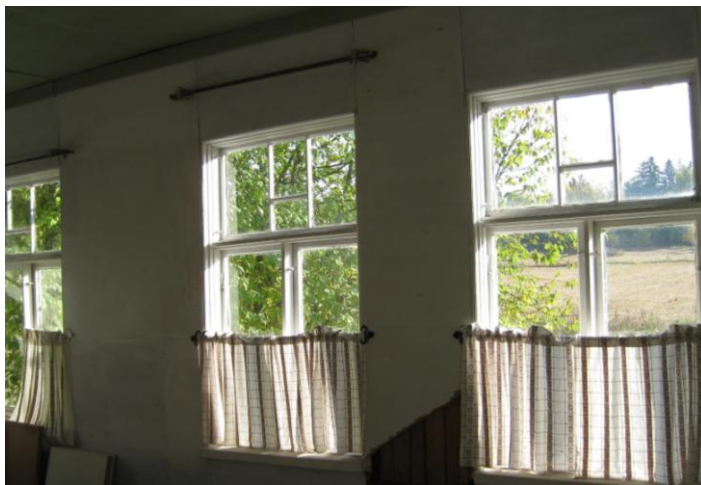
Kuva 14. Alkuperäisiä ikkunoita Laurilan salissa..
