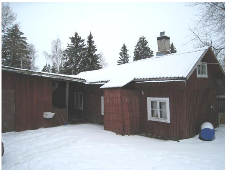
Kuva 8. Piharakennukset on yhdistetty katoksella.
