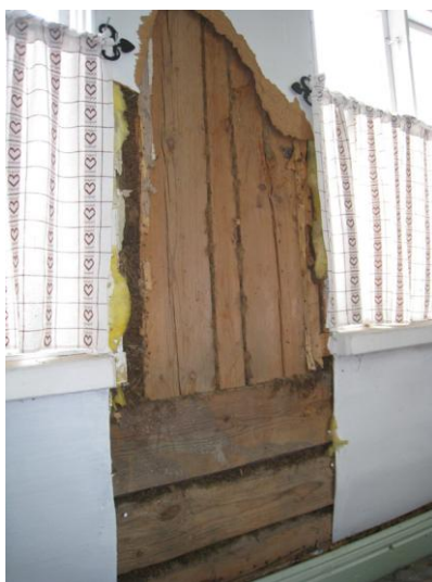
Kuva 11. Ikkunoiden väliset hirret ovat pystyssä.
