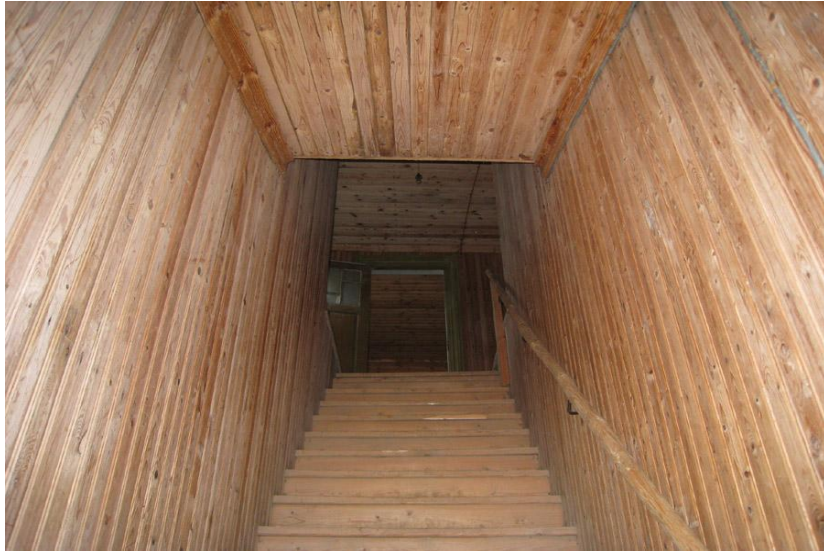
Kuva 7. Portaat yläkertaan ovat hyväkuntoiset ja leveät. Helmiponttipaneeliseinät ovat maalaamattomat.
