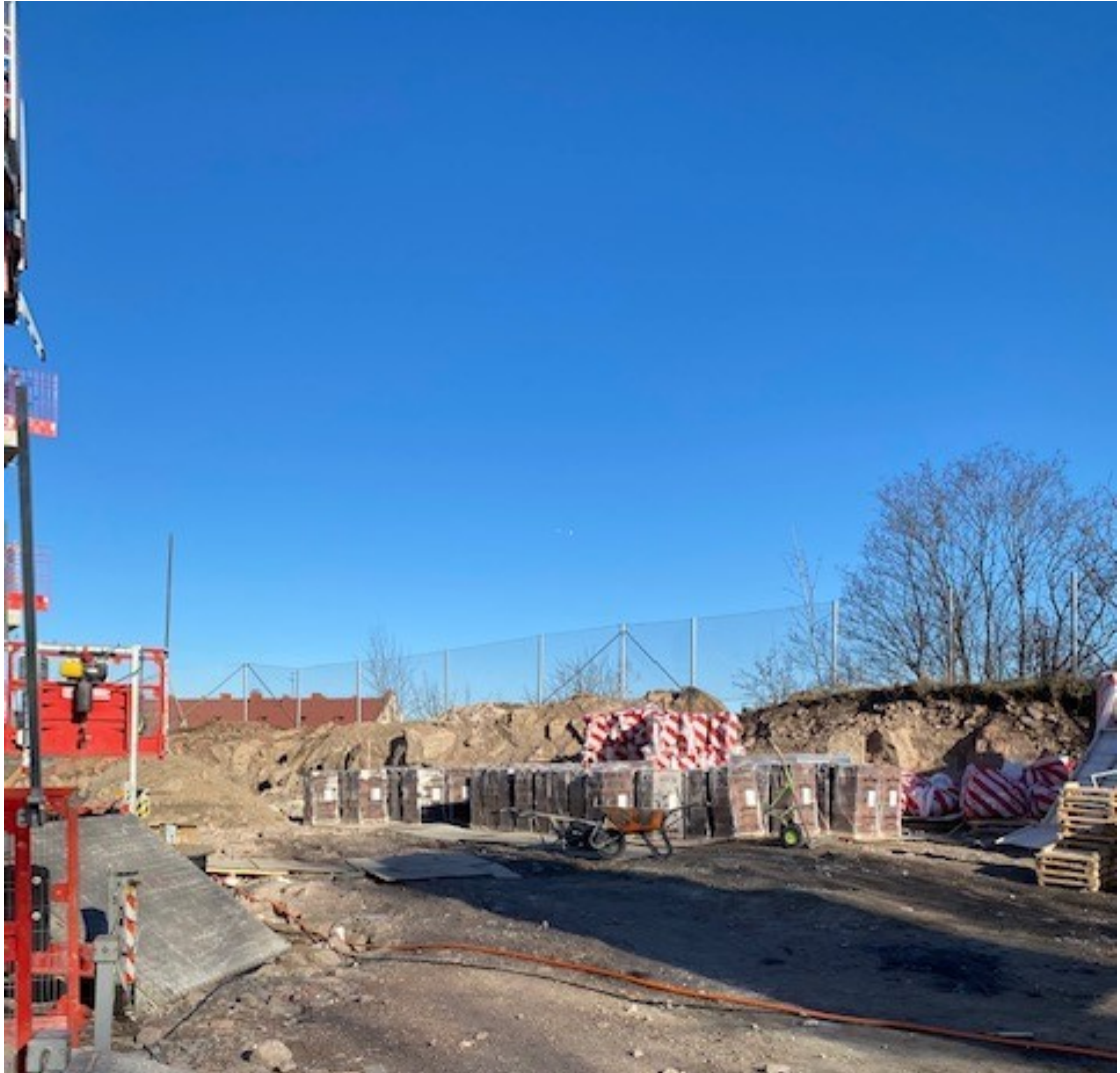
Kuva 12. Tiililetkojen varastointipaikka työmaalla.
