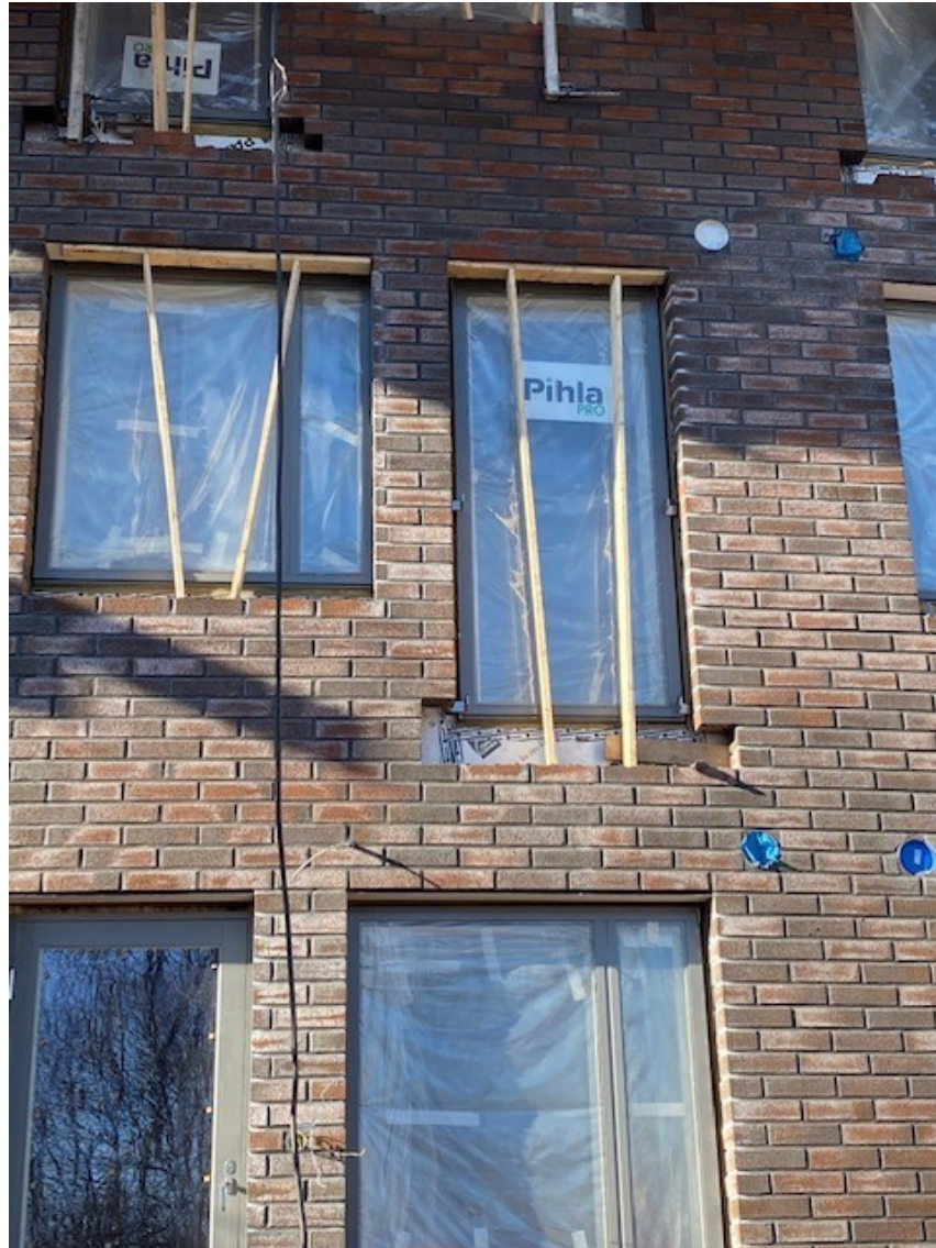
Kuva 16. Ranskalaisen parvekkeen muurattava uloke jätetty pois.
