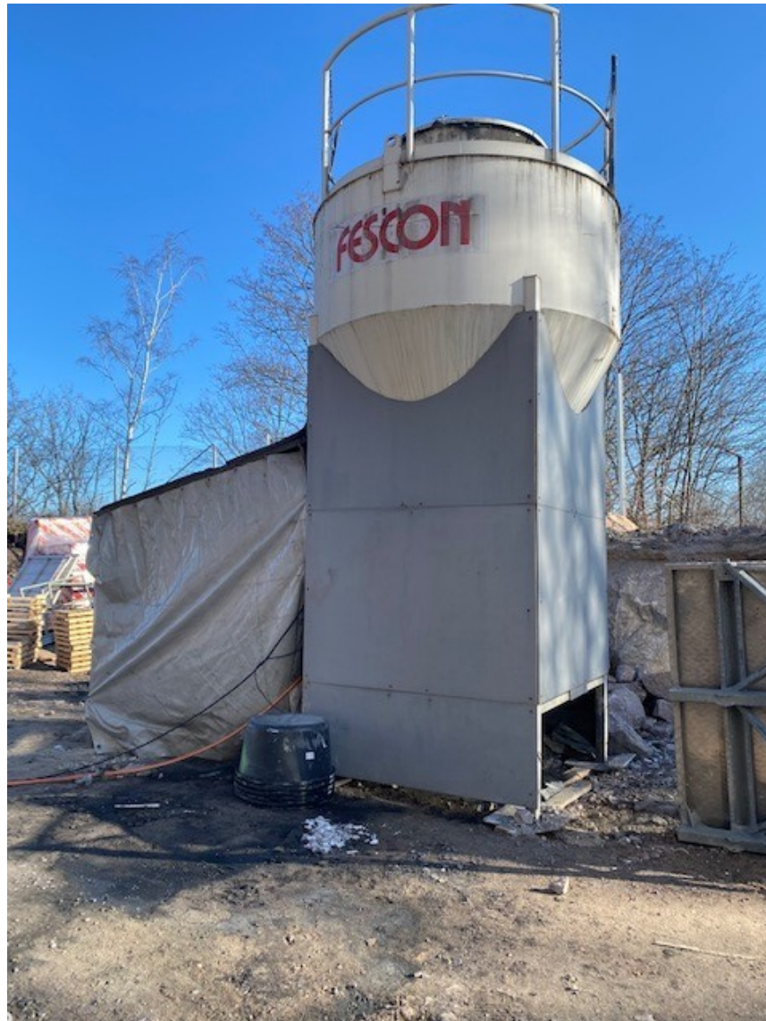
Kuva 13. Laastisiilon sijainti työmaalla.
