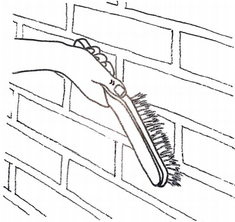
Kuva 10. Tiilien pinta harjataan puhtaaksi (Rakennustieto Oy 2010).
