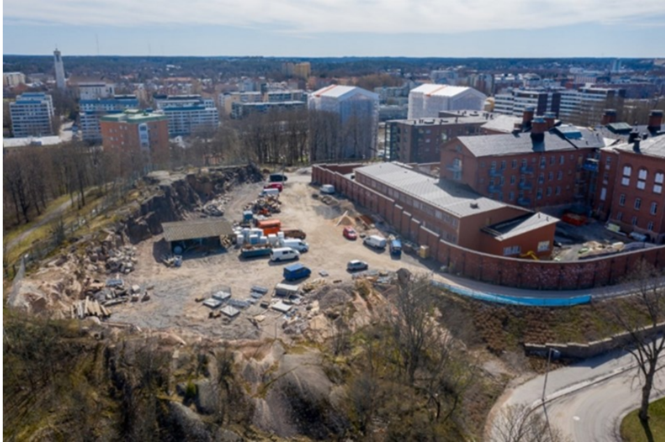
Kuva 1. Työmaa-alue (Peab Oy 2020).
