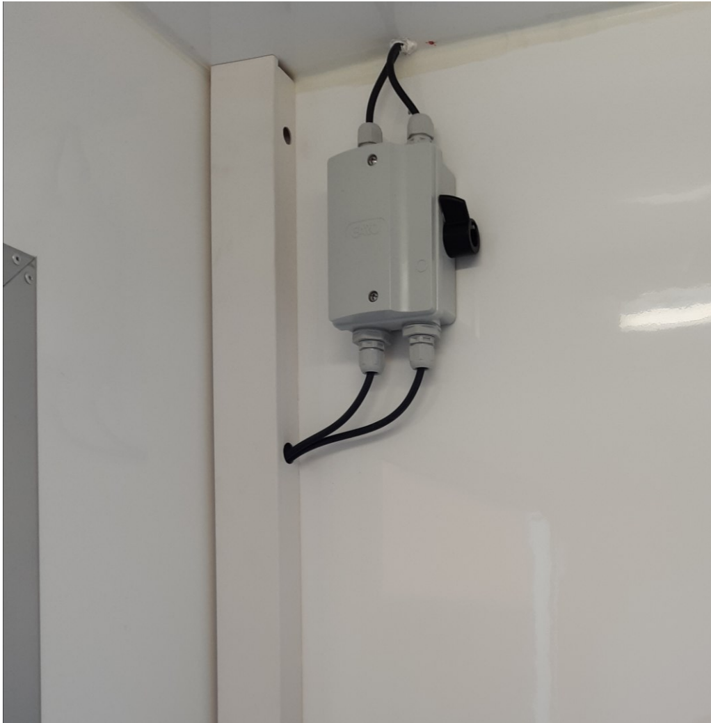
Kuva 10. Aurinkopaneelien turvakytkin asennus (Kuva: Tuomas Hirvonen).
