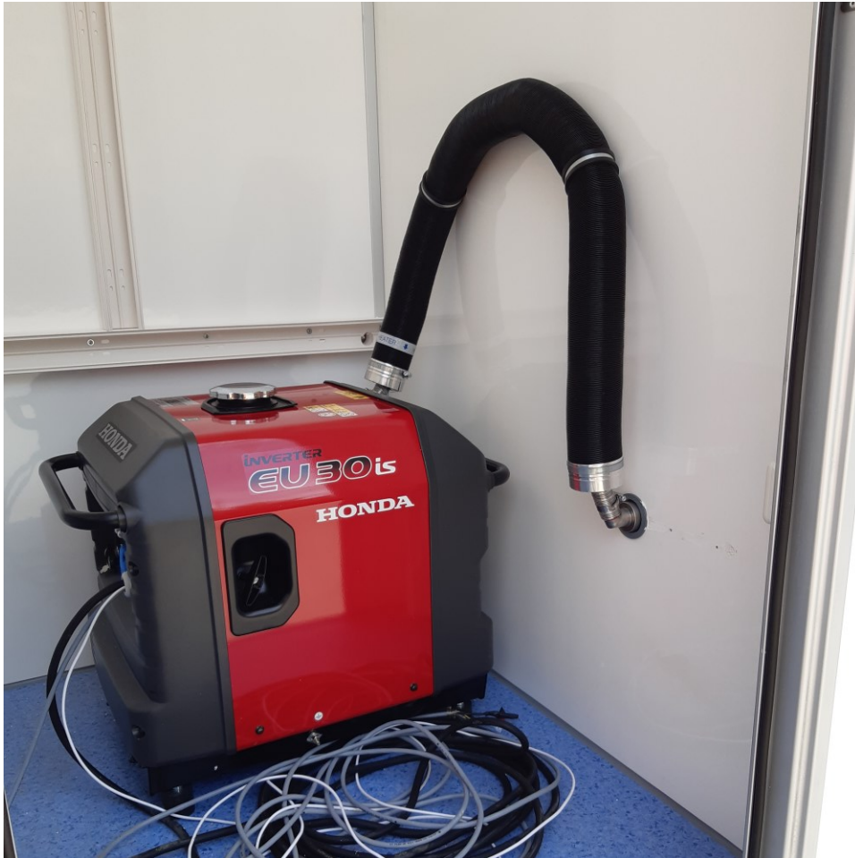
Kuva 19. Lisäpakoputken asennus ja pakoputken seinäläpivienti (Kuva: Tuomas Hirvonen).
