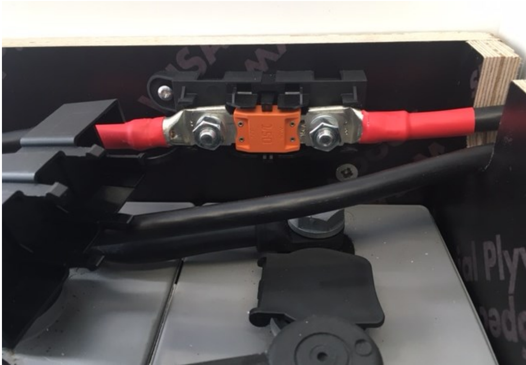
Kuva 29. 35 mm 2 kaapeli asennettuna 35-8 kaapelikengällä ja kutistesukalla. Kuvassa keskellä sulakekotelo ja 150 A Mega-sulake (Kuva: Tuomas Hirvonen).
