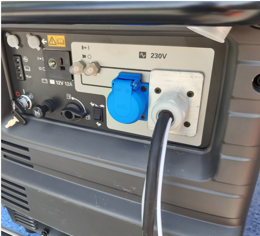
Kuva 20. Aggregaatin ohjauksen vaatima lisäkaapelointi ja kiinteäksi muutettu sähkönsyöttö (Kuva: Tuomas Hirvonen).
