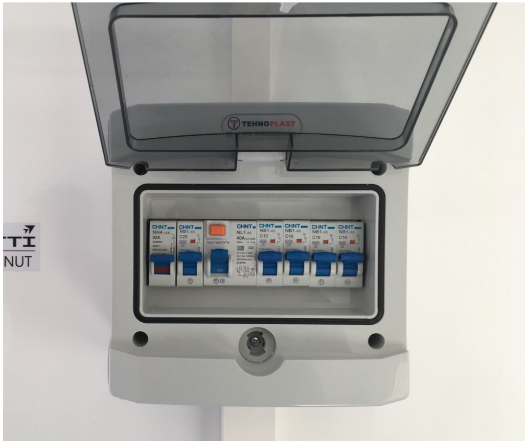
Kuva 3. Vaunun alkuperäinen sulaketaulu ja varokkeet (Kuva: Tuomas Hirvonen).
