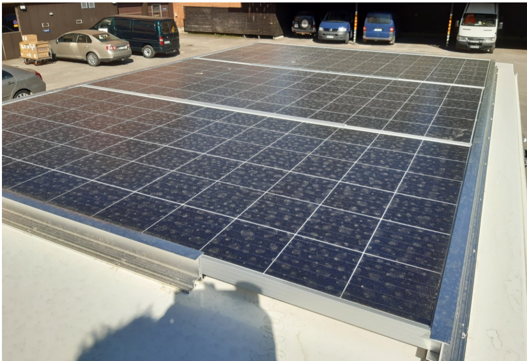
Kuva 8. Aurinkopaneelien kiinnitys alumiinisilla kiskoilla vaunun kattoon (Kuva: Tuomas Hirvonen).
