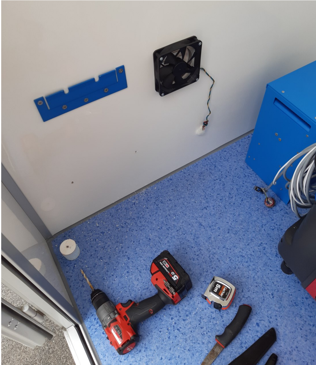
Kuva 25. Invertterin kiinnitystä varten seinään pultattu asennusrauta (Kuva: Tuomas Hirvonen).
