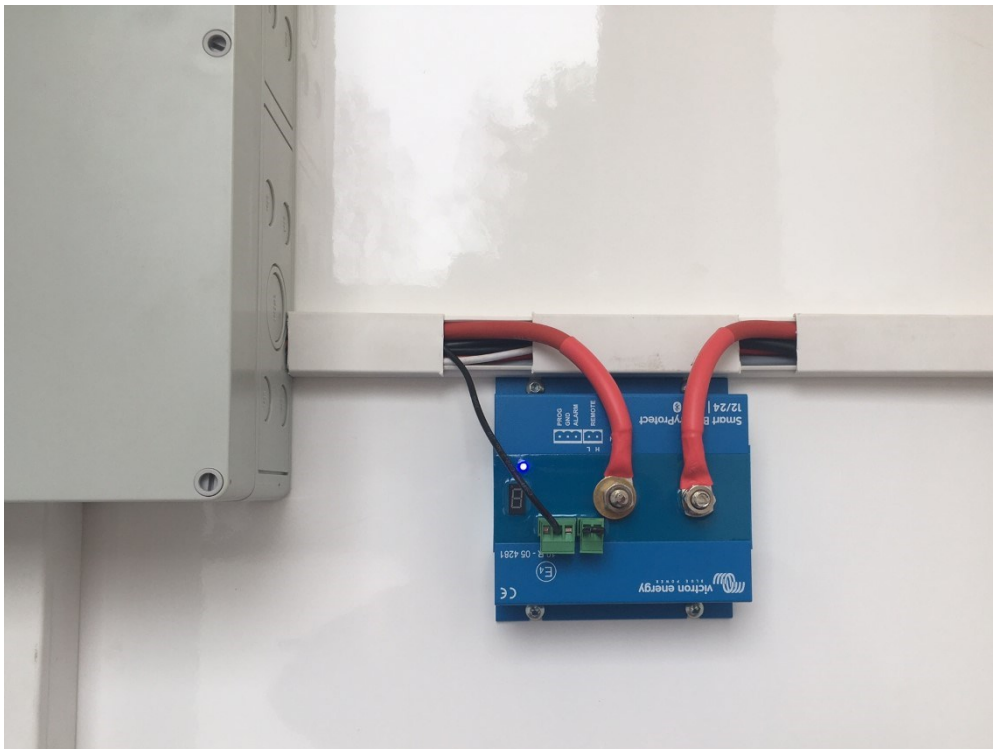
Kuva 18. Victron Energy Smart BatteryProtect akkuvahti asennettuna tutkimusvaunuun (Kuva: Tuomas Hirvonen).
