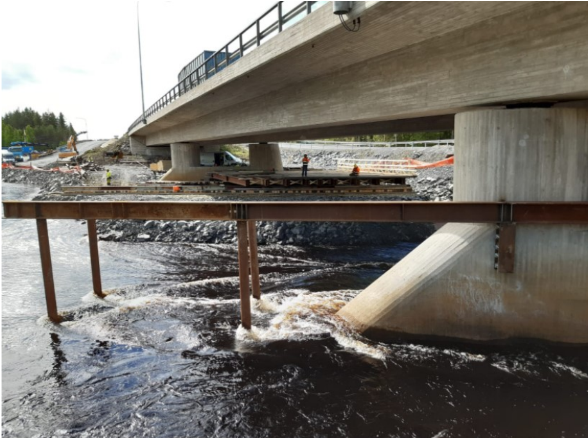
KUVA 8. Laakeripalkki asennettu paalujen ja konsoleiden päälle
