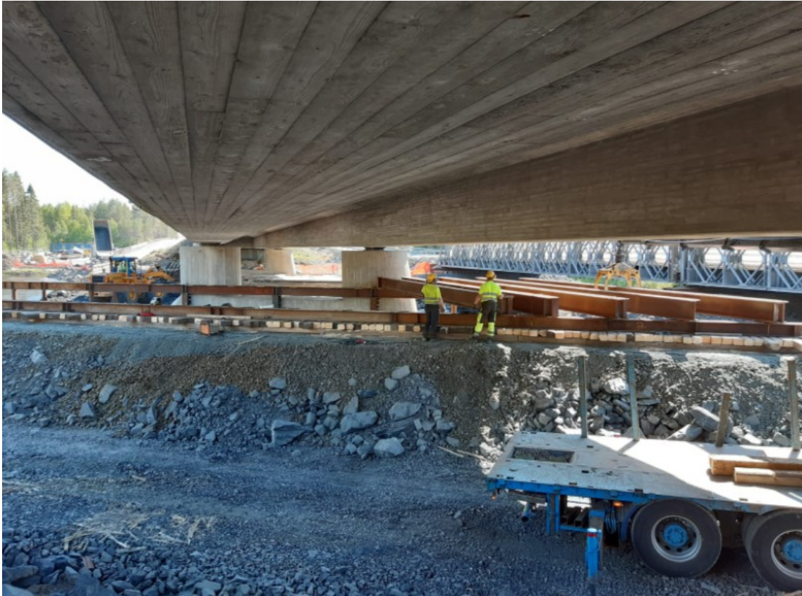
KUVA 10. HE500B-teräspalkkien nosto laakeripalkkien päälle HIAB-nosturilla
