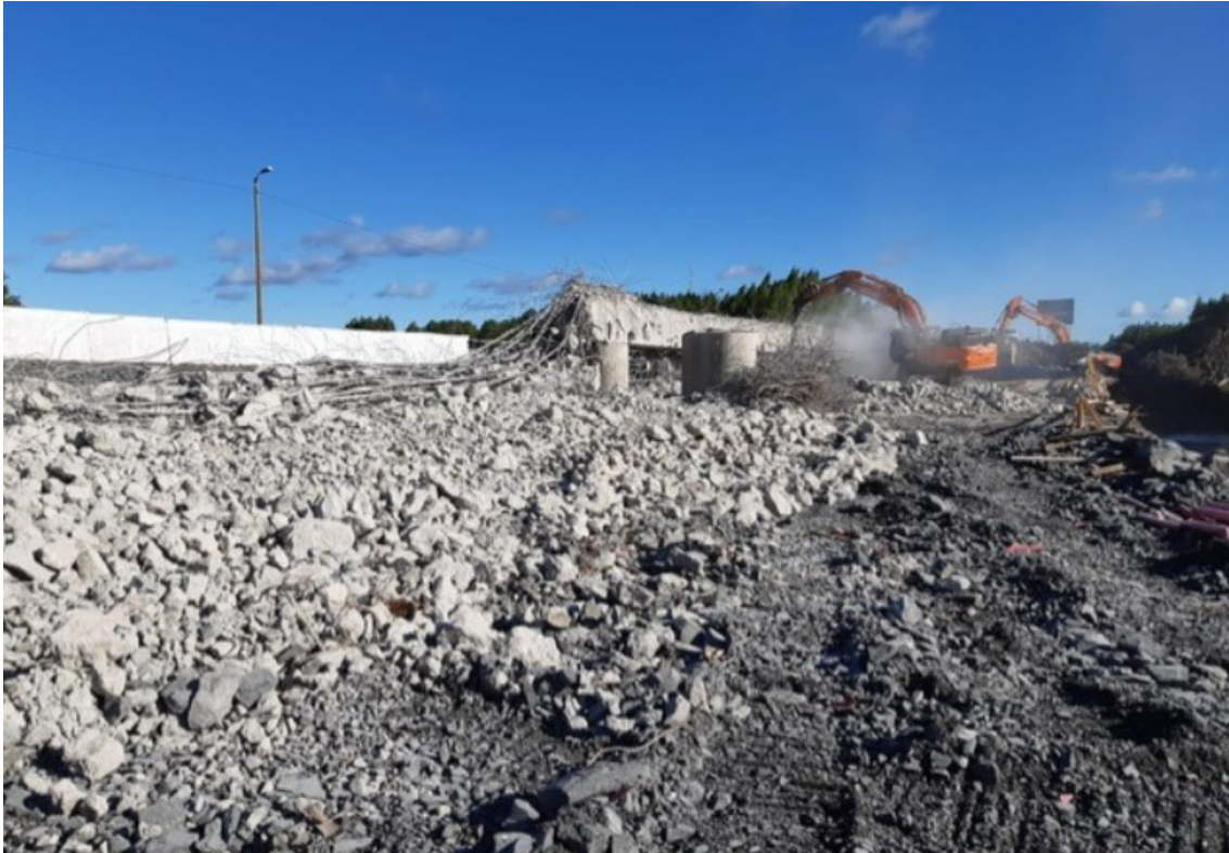
KUVA 14. Vanhan sillan päällysrakenteiden purku
