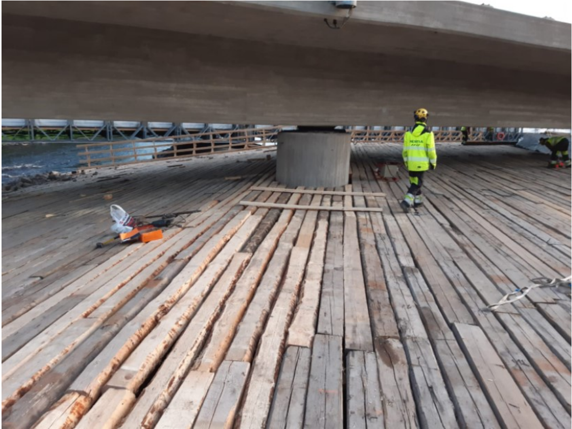
KUVA 13. Työsillan 2 valmis pelkkäkansi
