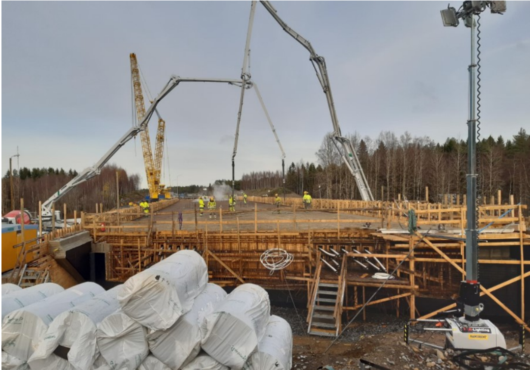
KUVA 17. Uuden sillan päällysrakenteiden valu
