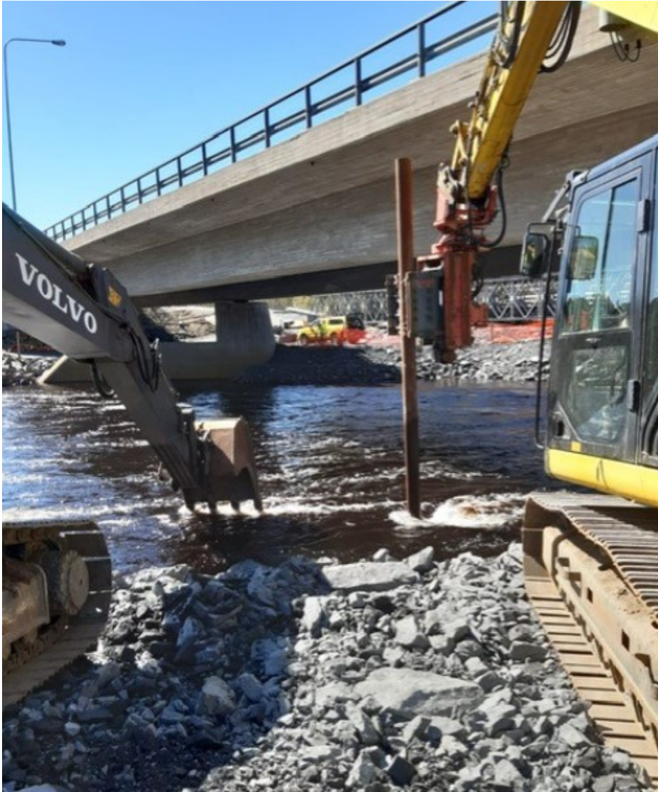
KUVA 5. Teräspalkkeiden asentaminen kaivinkoneella käyttäen sivuteiskijää
