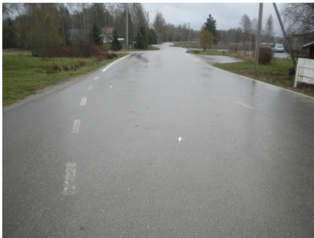
Kuva 17. Erittäin hyvälaatuinen päällyste, ei vaurioita
