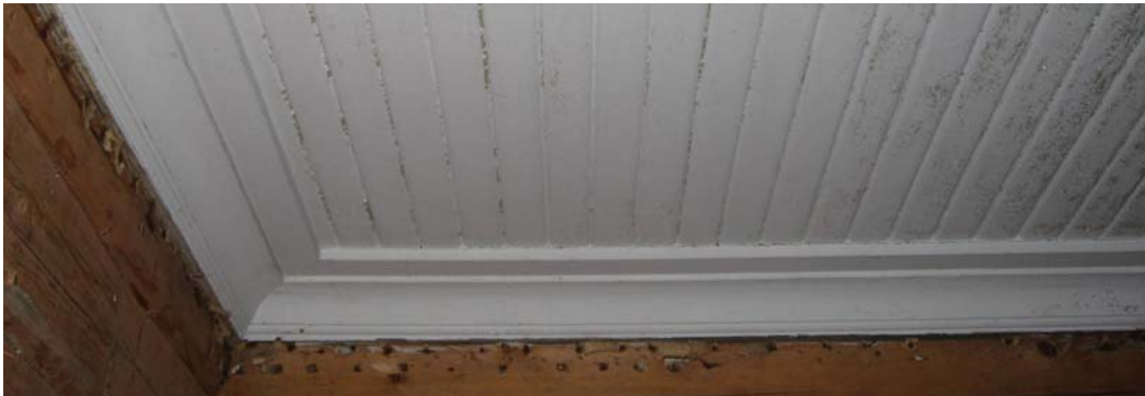
Kuva 10. Kattolistoja ja -panelointeja. (Nevalainen. 2011)
