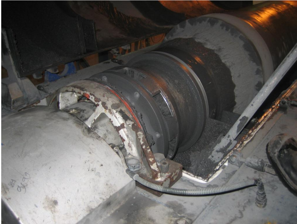
Kuva 7. Dekanterilingon kiintoaineen purkupää kansi avattuna.
