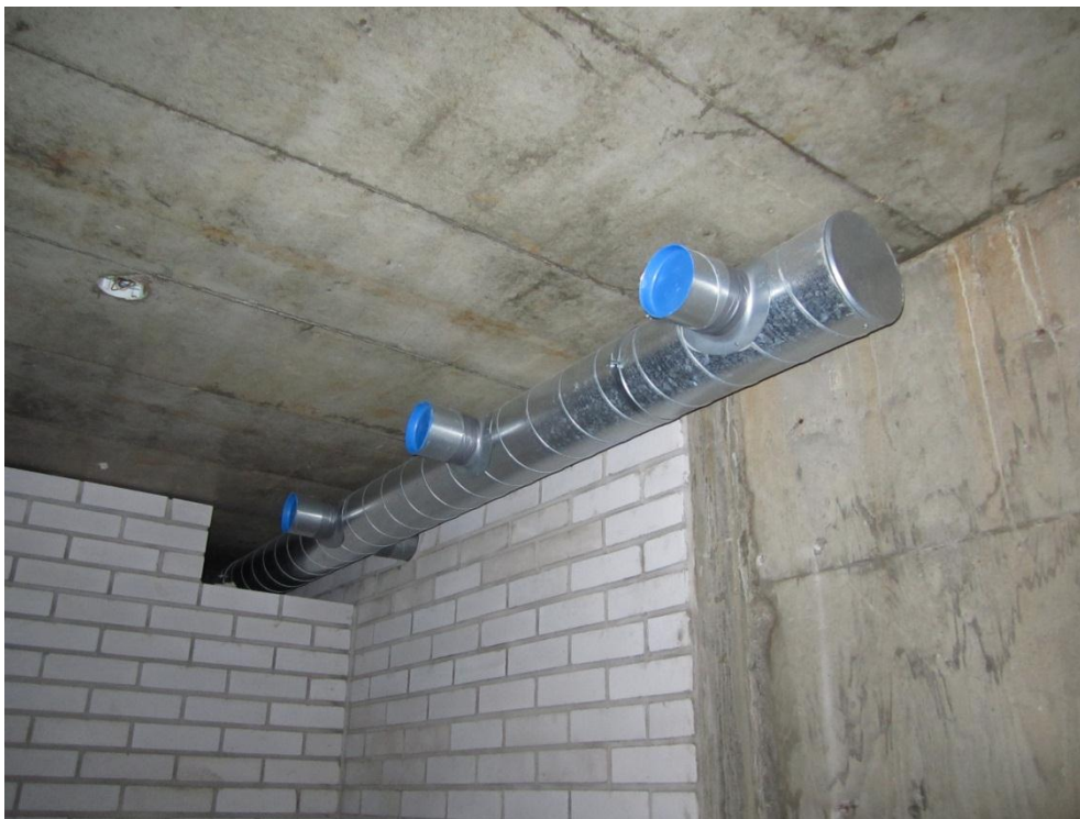
Kuvio 7. Ilmanvaihtokanavat tulpattiin aina työvaiheen valmistuttua ja taukojen ajaksi.
