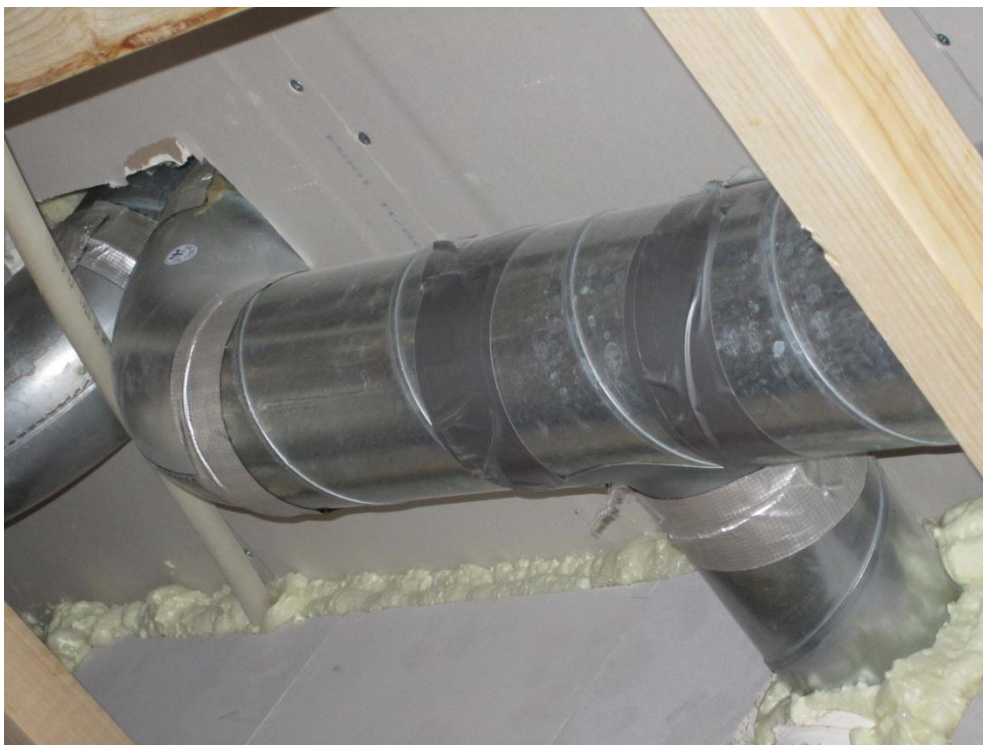
Kuvio 6. Ilmanvaihtokanavat liitettiin ilmastointiteipillä yhteen.
