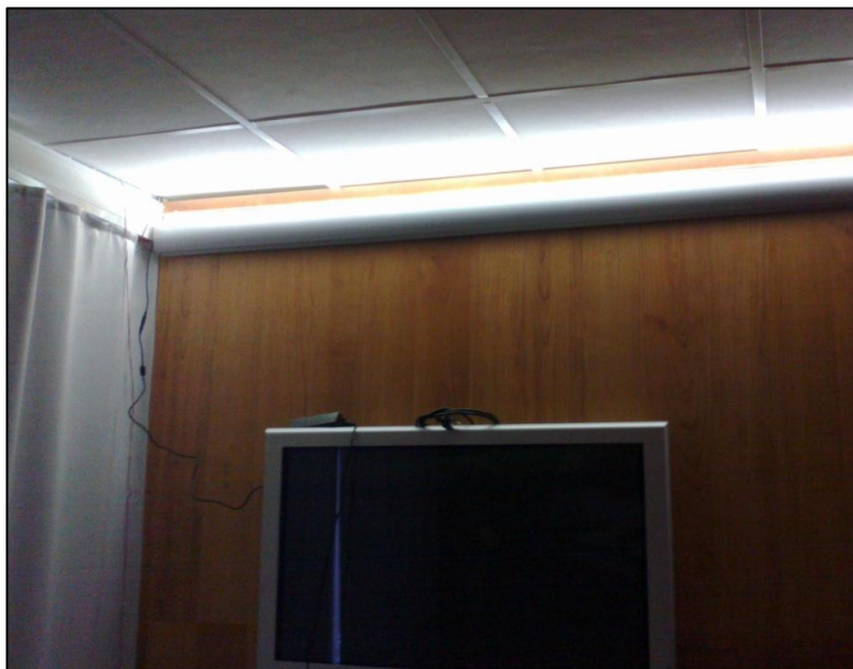
Kuva 6. Prototyyppi asennettuna mallihuoneeseen.
