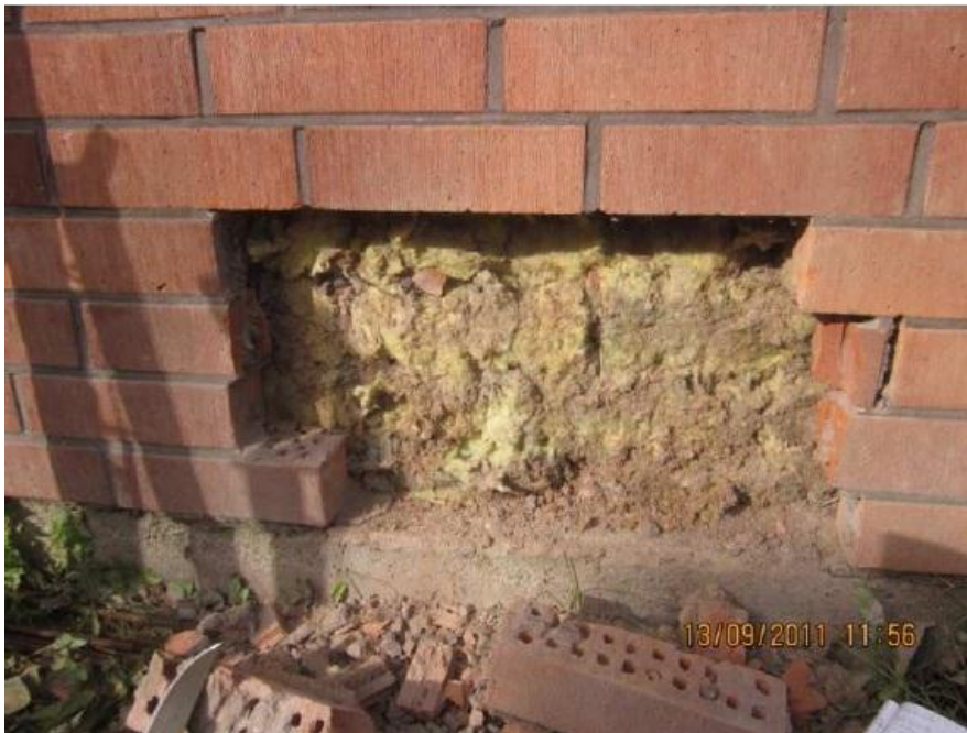
KUVA 10. Päätyseinän rakenneavaus. (20, s. 9)
