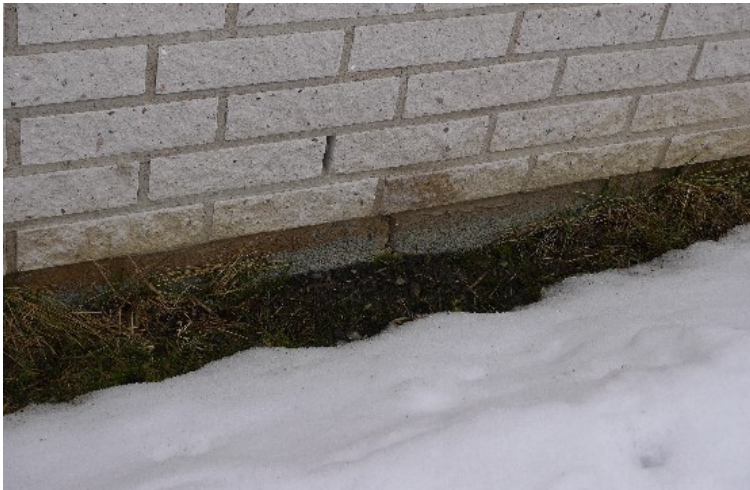
Kuva 6: Sokkelia näkyy paikoin hyvin vähän (3.1.2)
