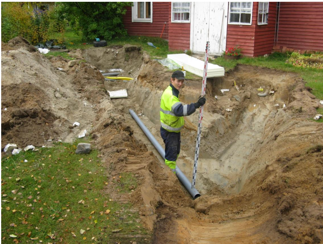
KUVA 16. Suoran putkilinjan korkeusmittaus
