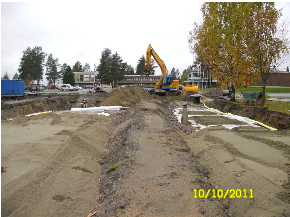
KUVA 20. Leikkauspohjaa ja rakennekerroksia, Terveystie
