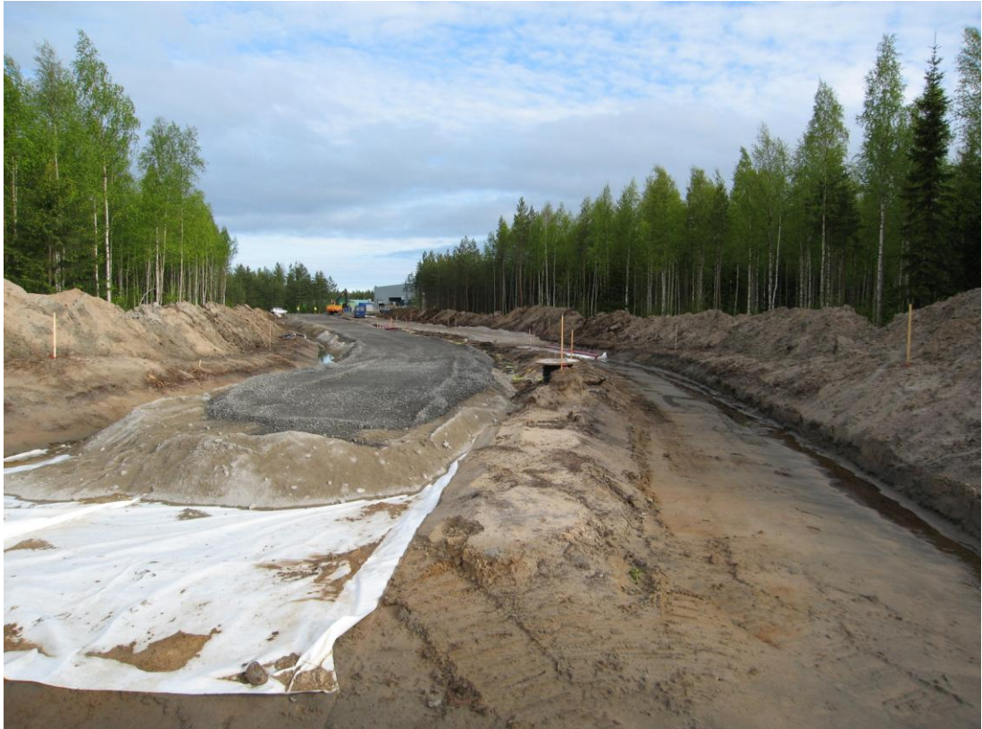
KUVA 17. Perinteinen tierakenteen mittausmerkintä
