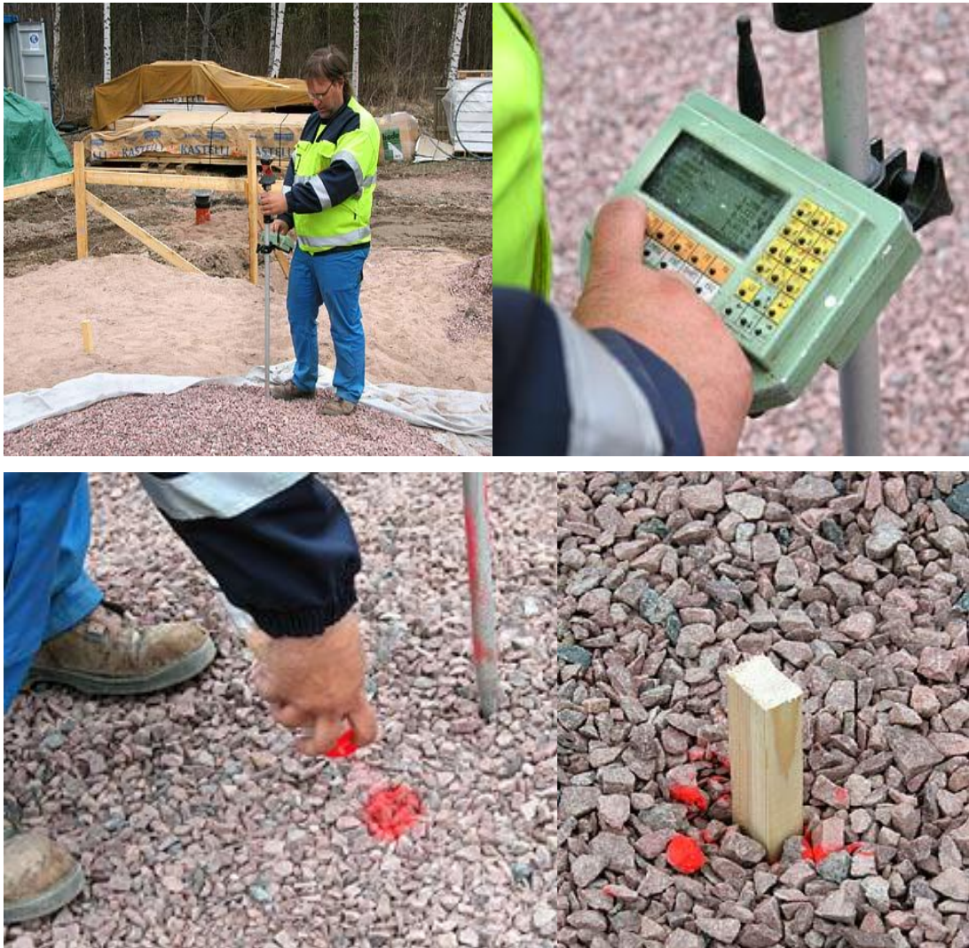
KUVAT 9 – 12. Robottitakymetrillä mittaus
