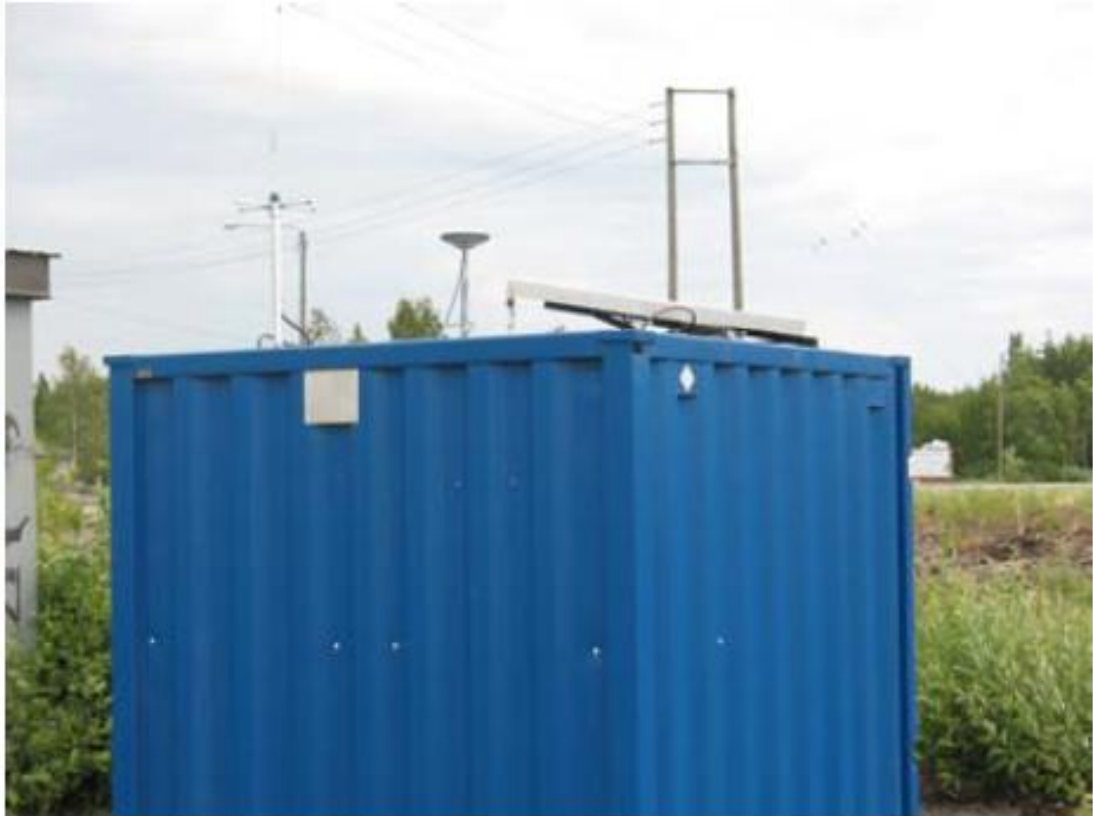
KUVA 4. Työkoneautomaation tukiasema, jonka säteen kantavuus n. 3,5 km (Heikkilä, 2009.)
