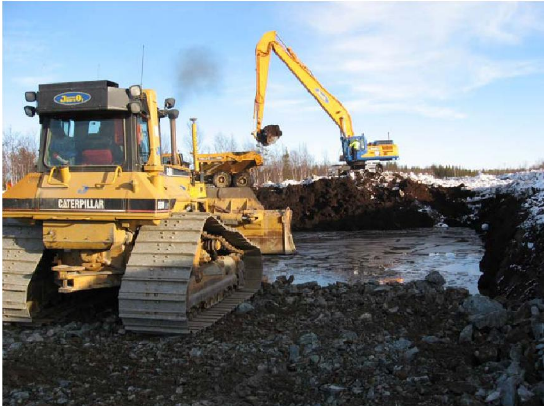
KUVA 1. Työkoneautomaation hyödyntäminen tierakenteen maanleikkauksessa ja täytössä
