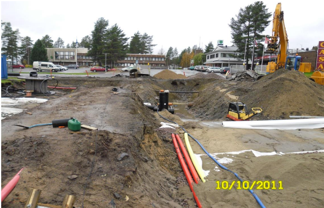
KUVA 19. Hulevesiviemärin kaivantoa, Terveystie
