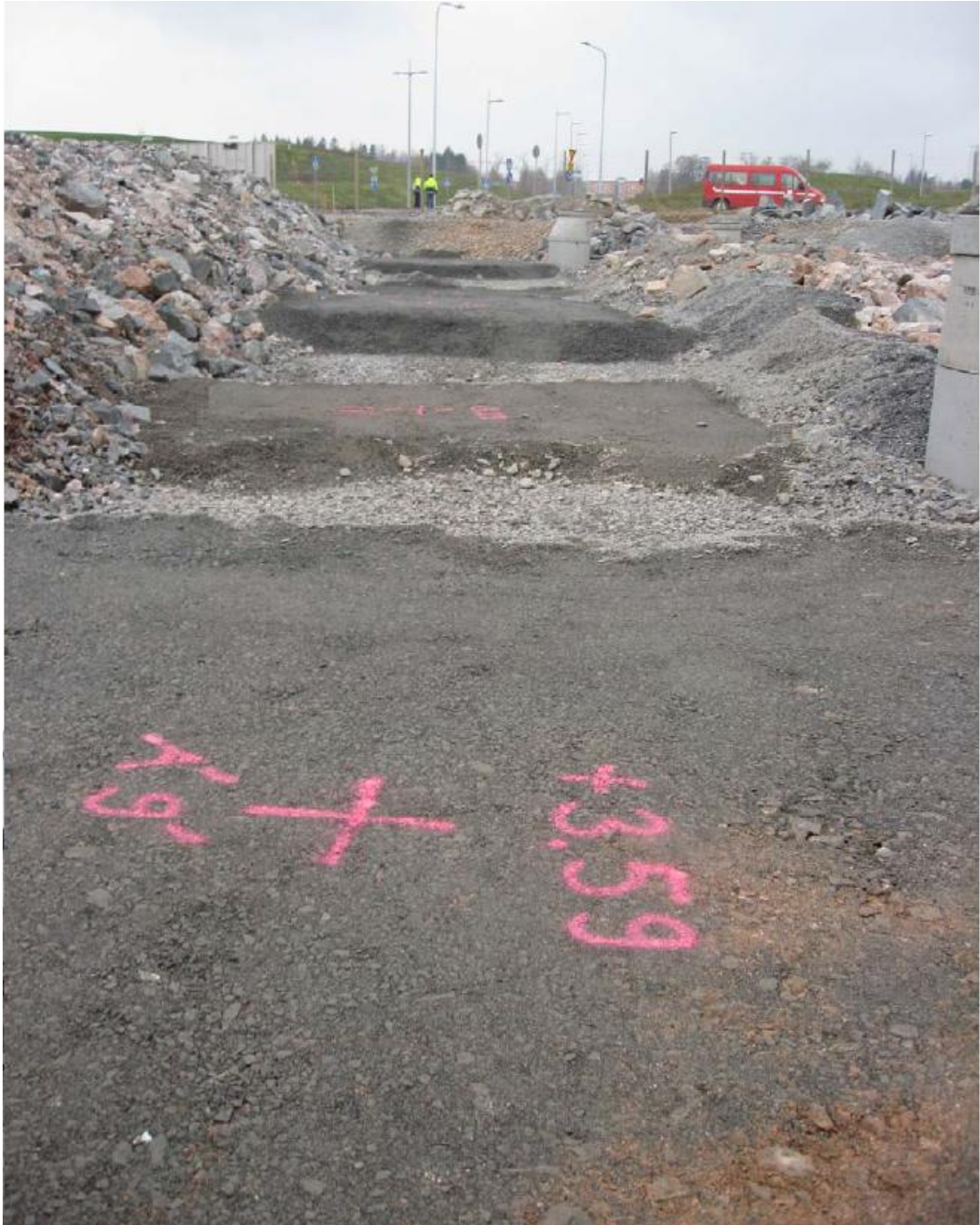
KUVA 5. Koneautomaatio on erinomainen esimerkiksi talon pohja- ja perustusrakentamisessa (Heikkilä, 2009.)
