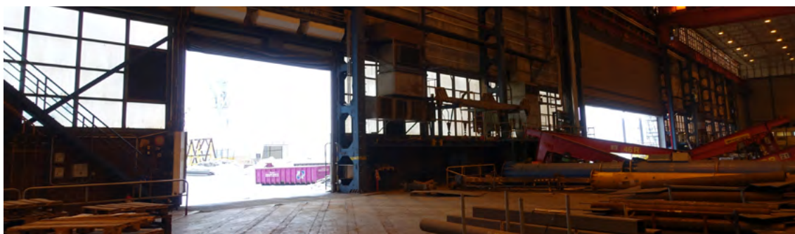
Kuva 8. Telakkahallin aukinaisia ovia. Kuva: Teija Järvenpää.
