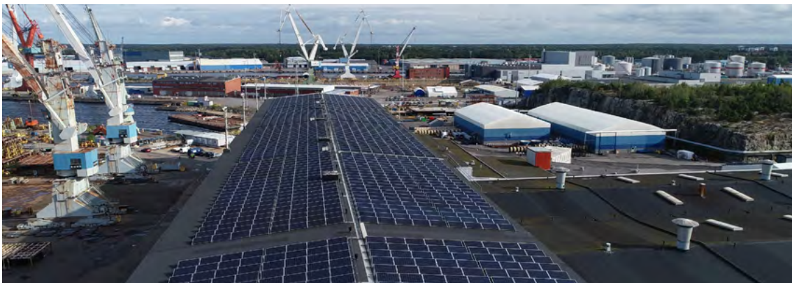
Kuva 5. Aurinkovoimala Rauman Meriteollisuuskiinteistöjen hallin katolla. Kuva: Teemu Heikkinen.
