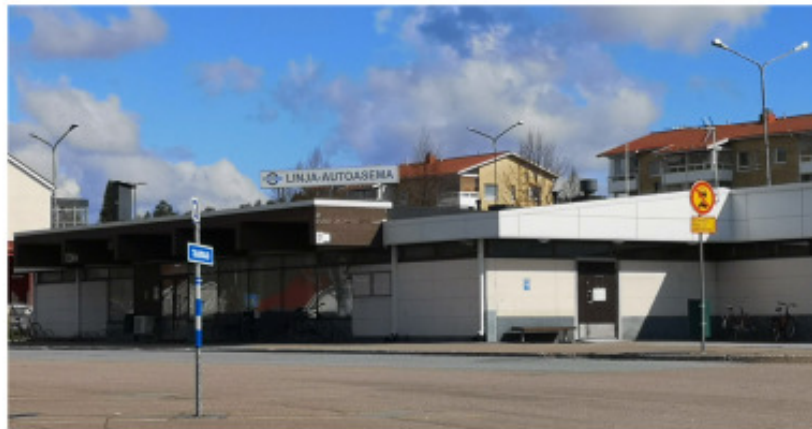
Kuva 4. Linja-autoaseman rakennus vaatii tulevaisuudessa päätöksiä.
