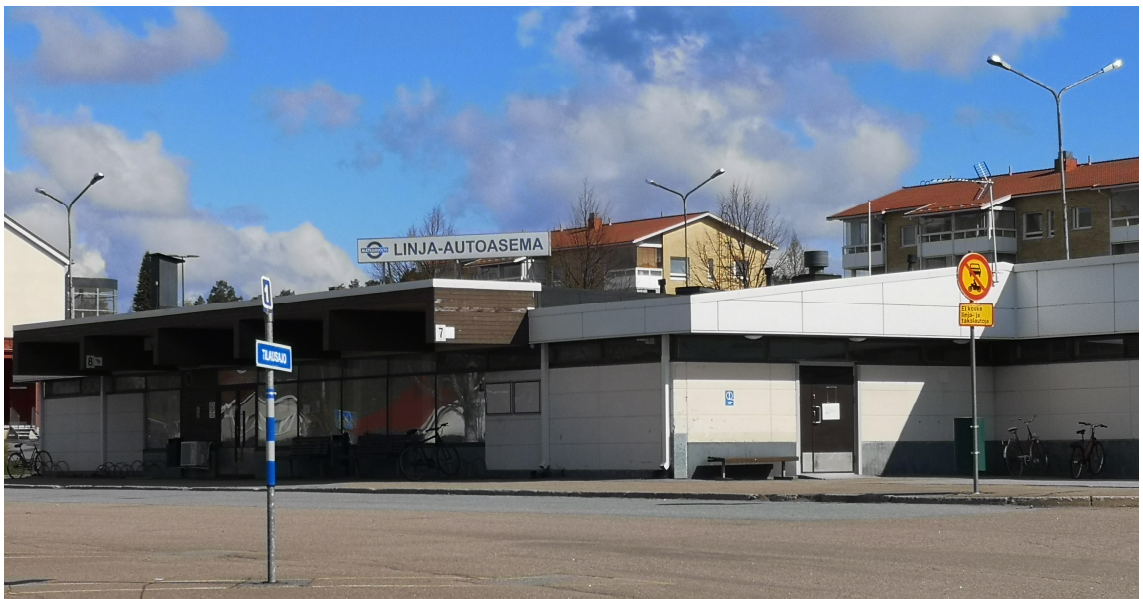
Kuva 9. Linja-autoaseman rakennus vaatii tulevaisuudessa päätöksiä.
