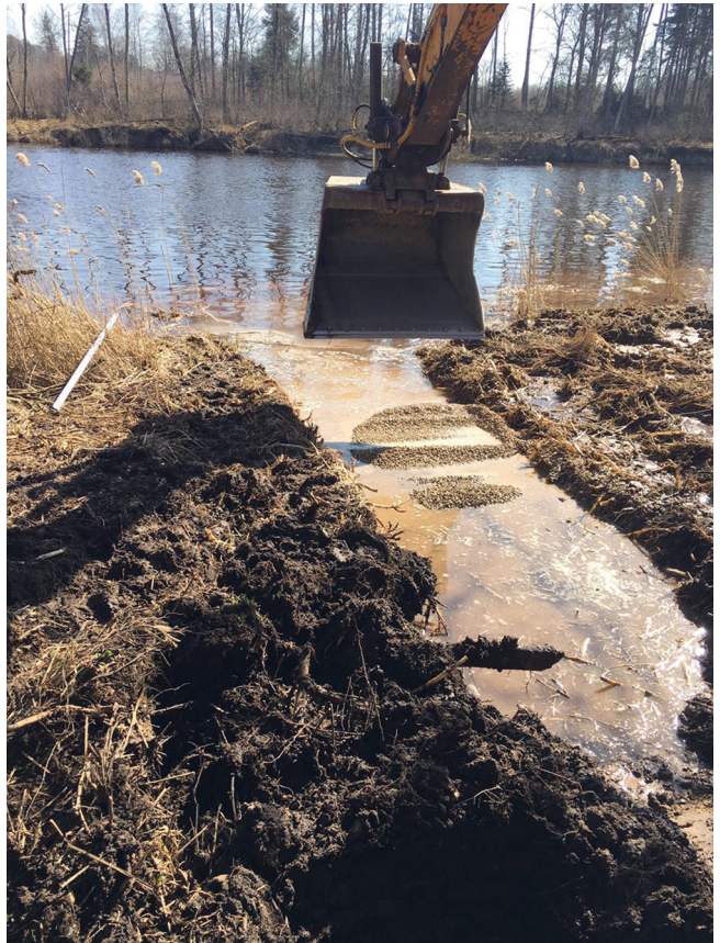
Kaivaustöitä Ogressa, Latviassa, tulvasensoreiden asennusta varten maaliskuussa 2020. Kuva: © Janis Rubulis.
