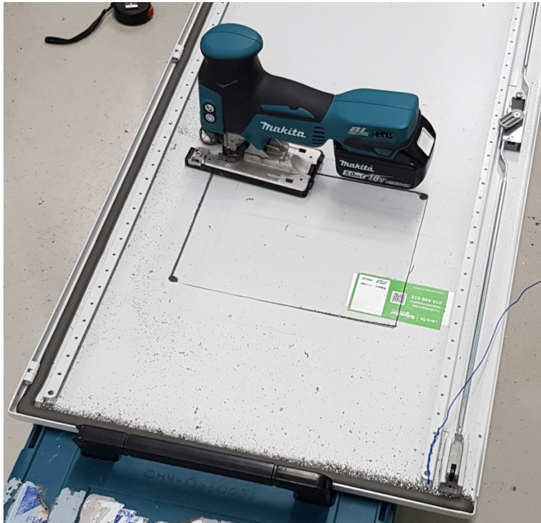
Kuva 13. Käyttöpaneelin aukon teko
