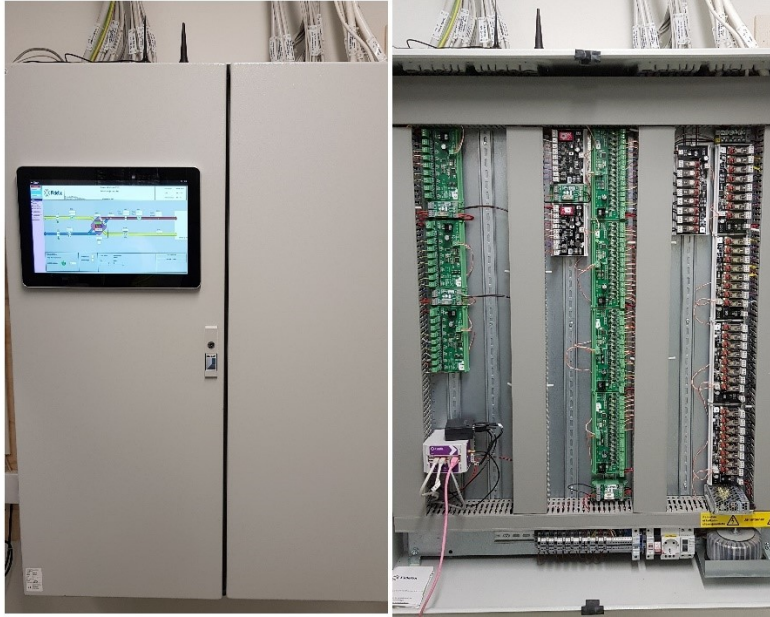
Kuva 20. Valmis VAK asennustöiden jälkeen ulko- ja sisäpuolelta
