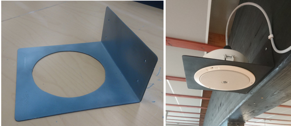
Figur 2. Bild på nyttillverkat fäste (vänster), och färdigt installerat fäste inkl. högtalare (höger).
