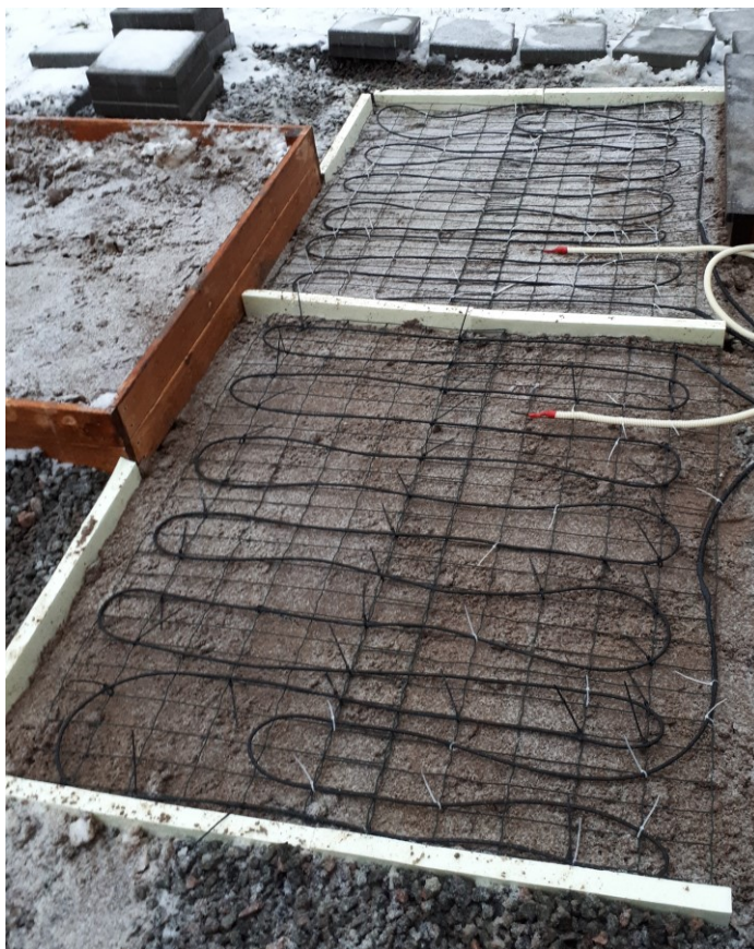
Kuva 6. Lämmityskaapeliin asennuskerroksen rakenne
