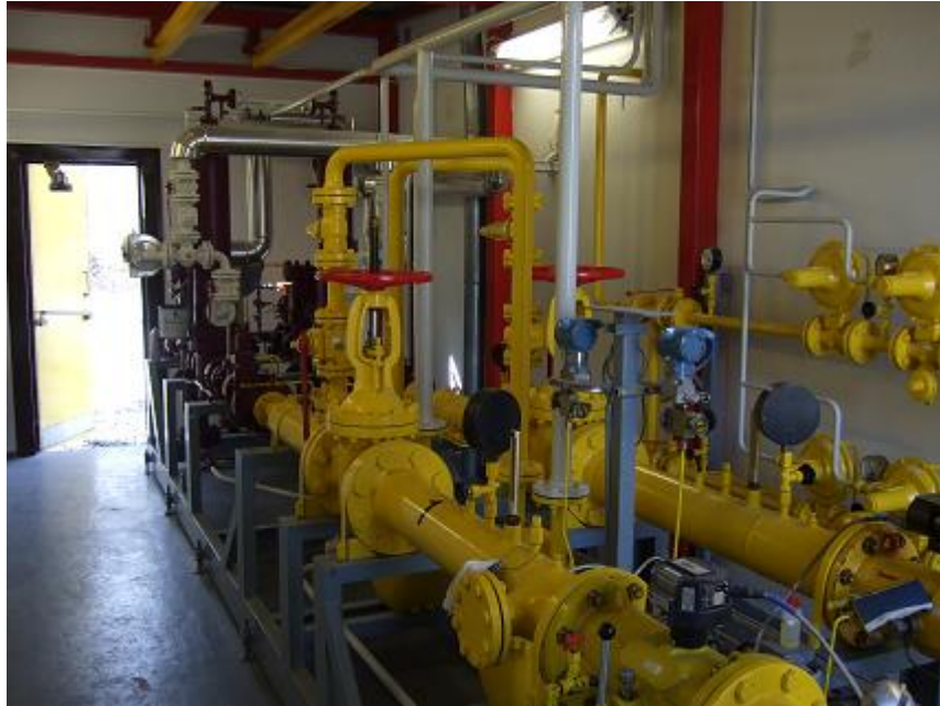
Kuva 5. Paineenvähennysaseman Ex-laitetila.
