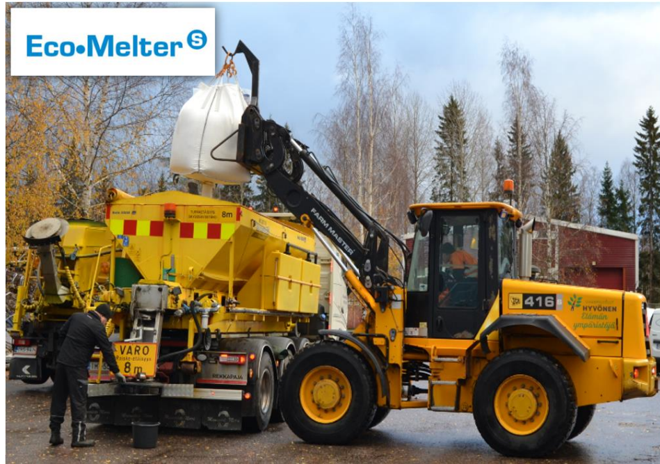
Kuva 27. Eco-Melter S -raemateriaalin kuormausta sirotteluautomaattiin (Taavitsainen 2018).
