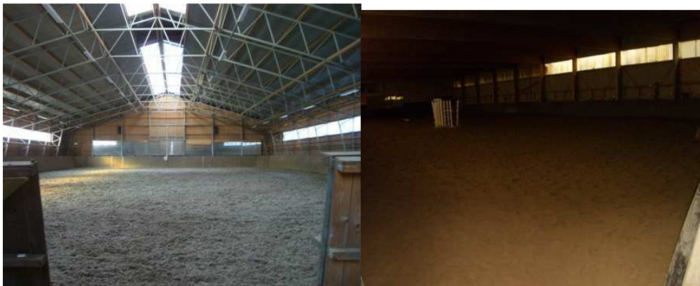
KUVIO 40 Päivänvalon hyödyntäminen suurella ikkunapinta-alalla säästää huomattavasti energiaa maneesissa.
