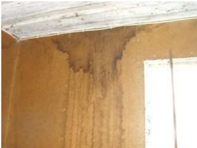
KUVIO 41 Vuoto tallin katossa aiheuttaa kosteusvaurioita rakenteisiin
