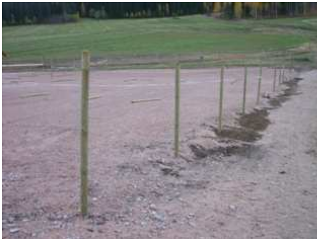
KUVIO 26 Rakenteilla olevia tarhoja, joissa kallistus keräilyjojan, lisäksi salaojitusta. Pohjana vettä läpäisevä, hevosille hyvä ja siistinä pysyvä sora.
