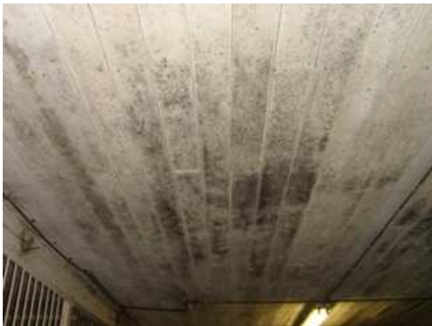
KUVIO 42 Home on vallannut tallin kattorakenteita
